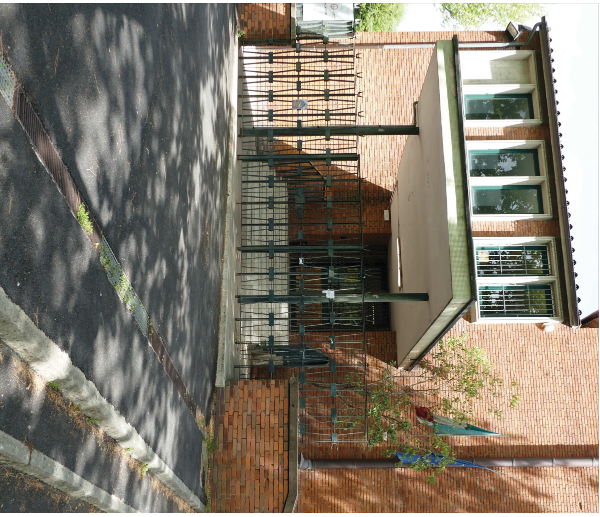
Ingresso principale della scuola materna dalla sommità della scala
