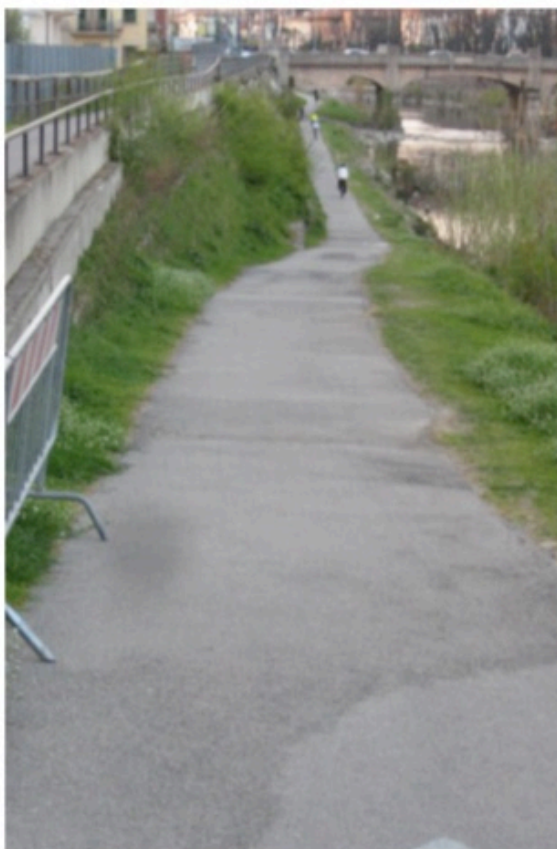
Fig. 85. Rampa 05_Vittoria_Dx - Stato attuale rampa Sud oggetto di intervento abbattimento barriera architettonica.
