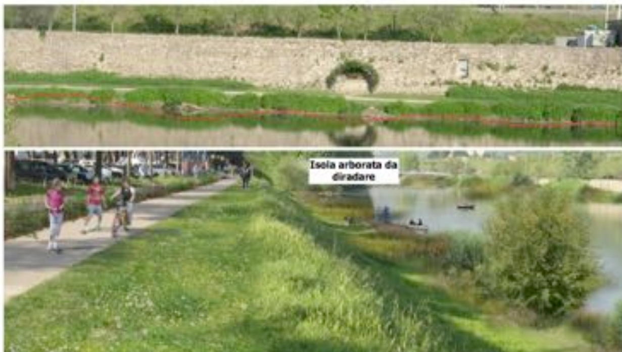
Fig. 48. Tratto 2 - Intervento 2.1.1.1 - Sponde dx e sx. Dettaglio.
