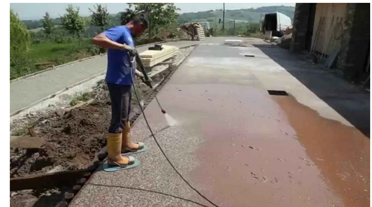
05 Operazione di lavaggio 1:50
