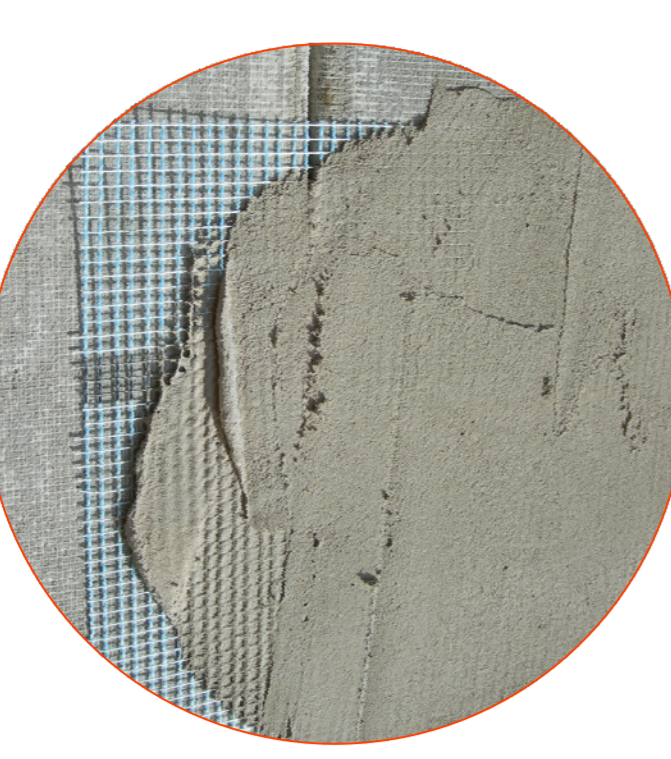
DETTAGLIO N'D5: Posa in opera della rete antisfessurazione e dell'intonaco esterno
