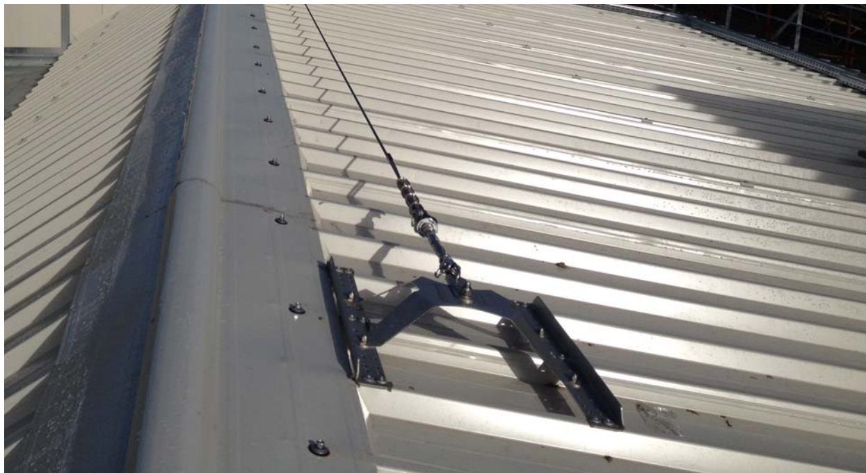
Esempio di nuova copertura metallica in pannelli sandwich installata su solaio piano esistente.
