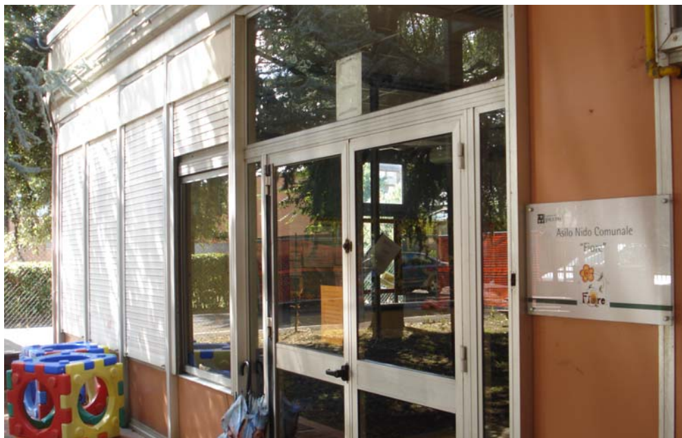
Infissi dell'edificio: telaio in alluminio e vetro singolo
