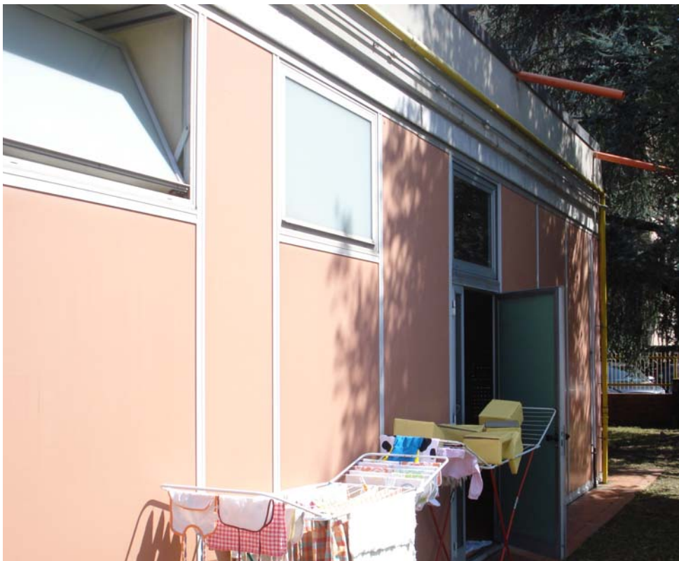
Parete perimetrali disperdenti dell'edificio
