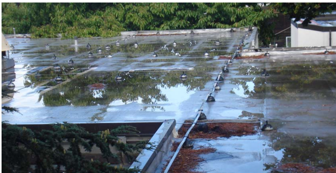
Copertura piana dell'edificio
