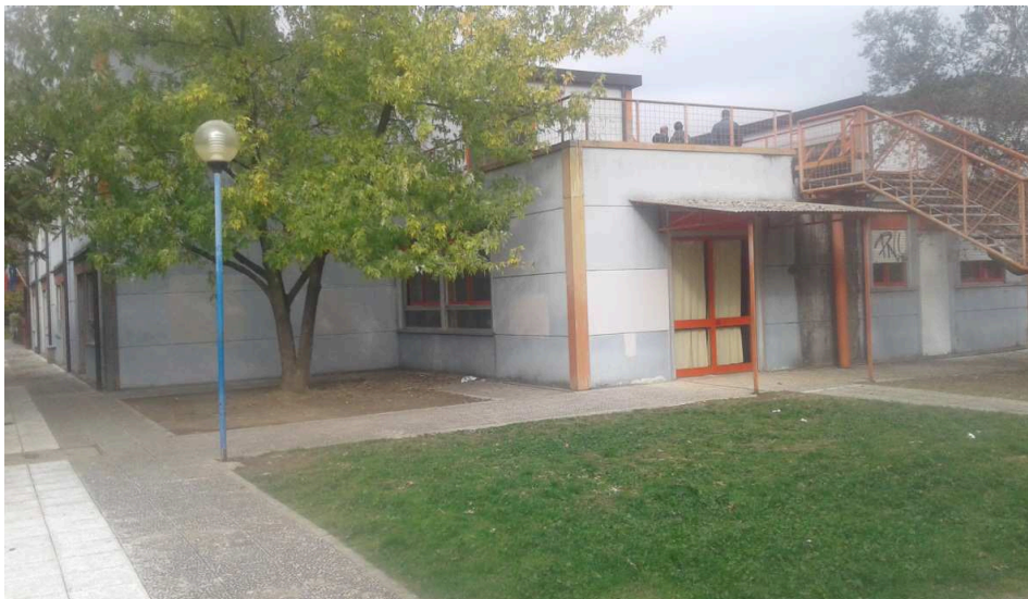
Parete perimetrali disperdenti dell'edificio
