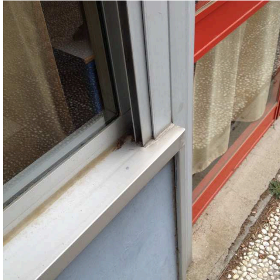
Infissi dell'edificio: telaio in alluminio e vetro singolo
