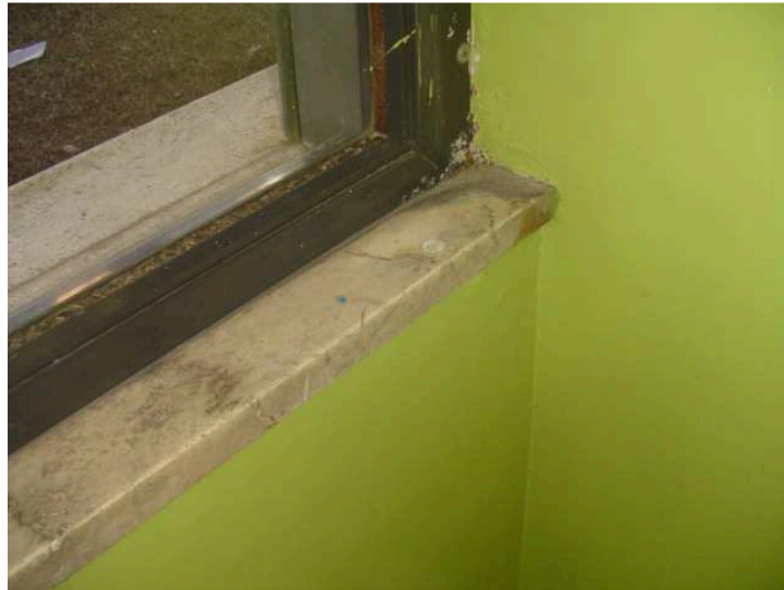
Infissi dell'edificio: telaio in alluminio e vetro singolo
