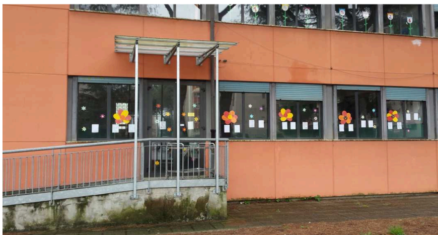
Parete perimetrali disperdenti dell'edificio
