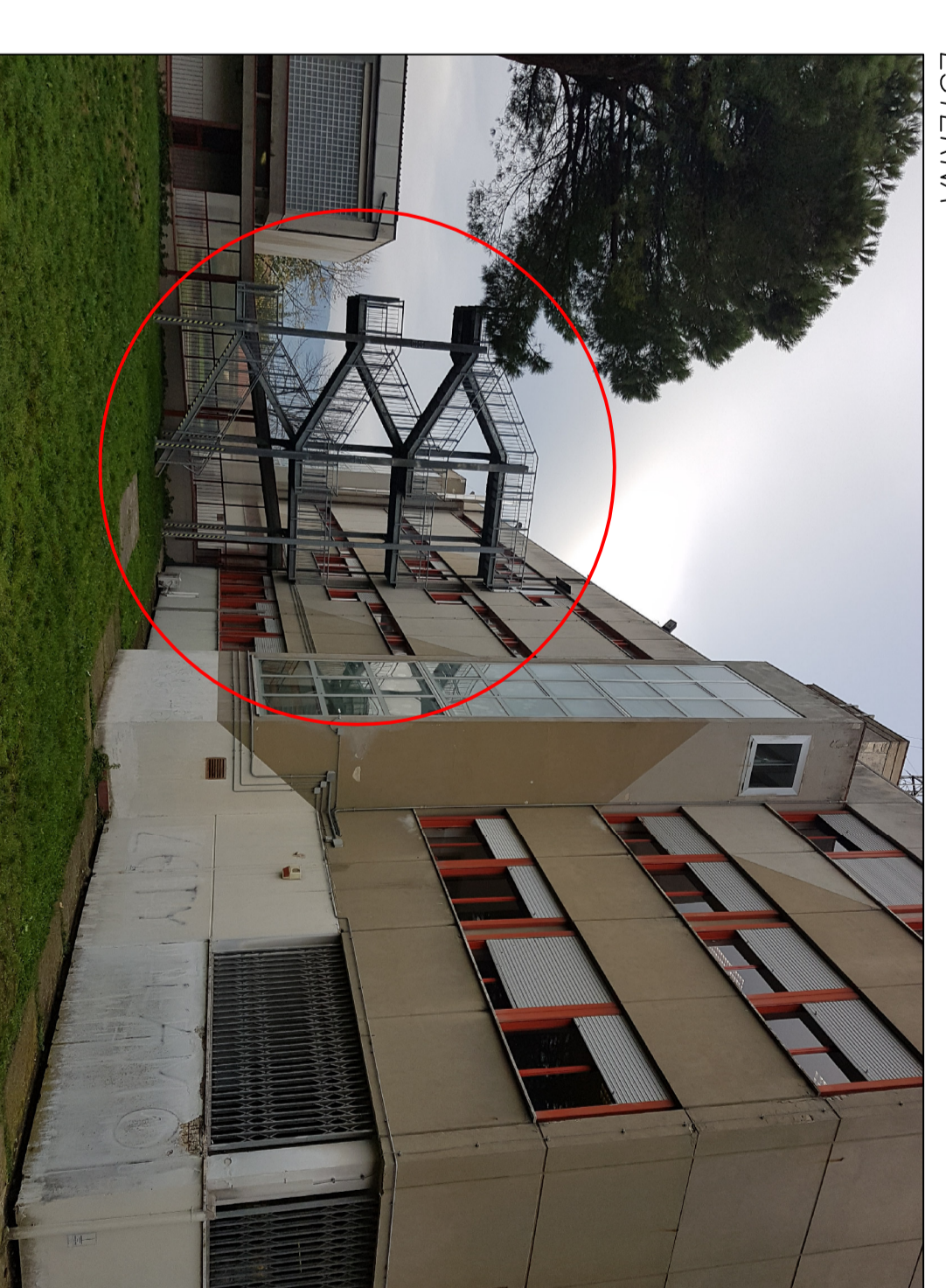
PART. N5: INTERFERENZA PONTEGGIO CON SCALA DI SICUREZZA ESTERNA
