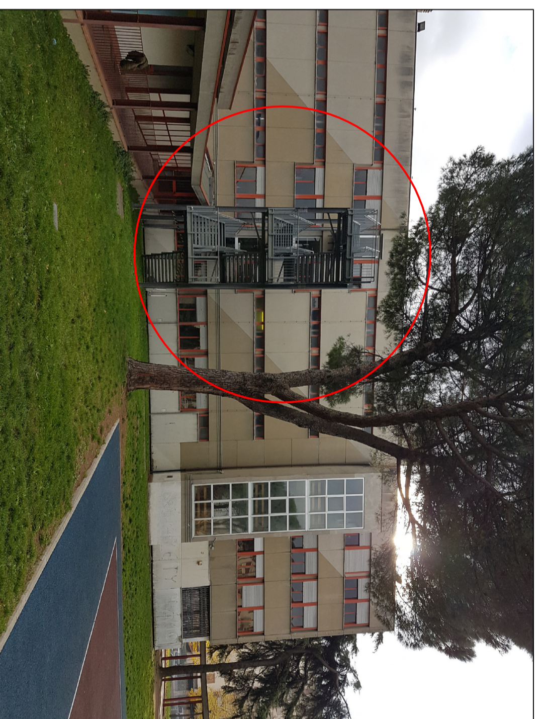
PART. N4: INTERFERENZA PONTEGGIO CON SCALA DI SICUREZZA ESTERNA
