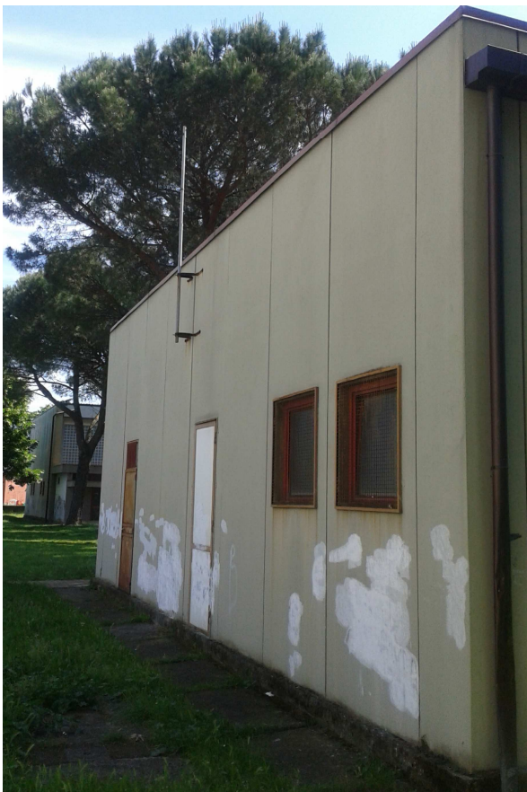
Foto 18 : prospetto ovest biblioteca
