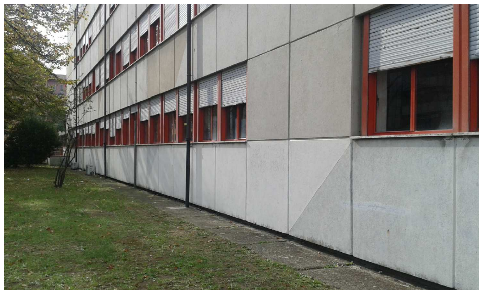
Foto 1: facciata principale scuola
