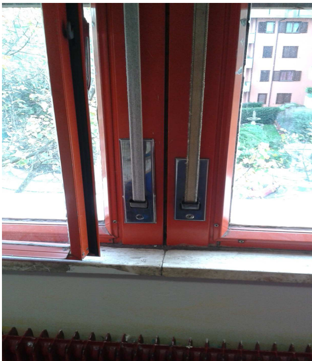
Infissi dell'edificio: telaio in alluminio e vetro singolo
