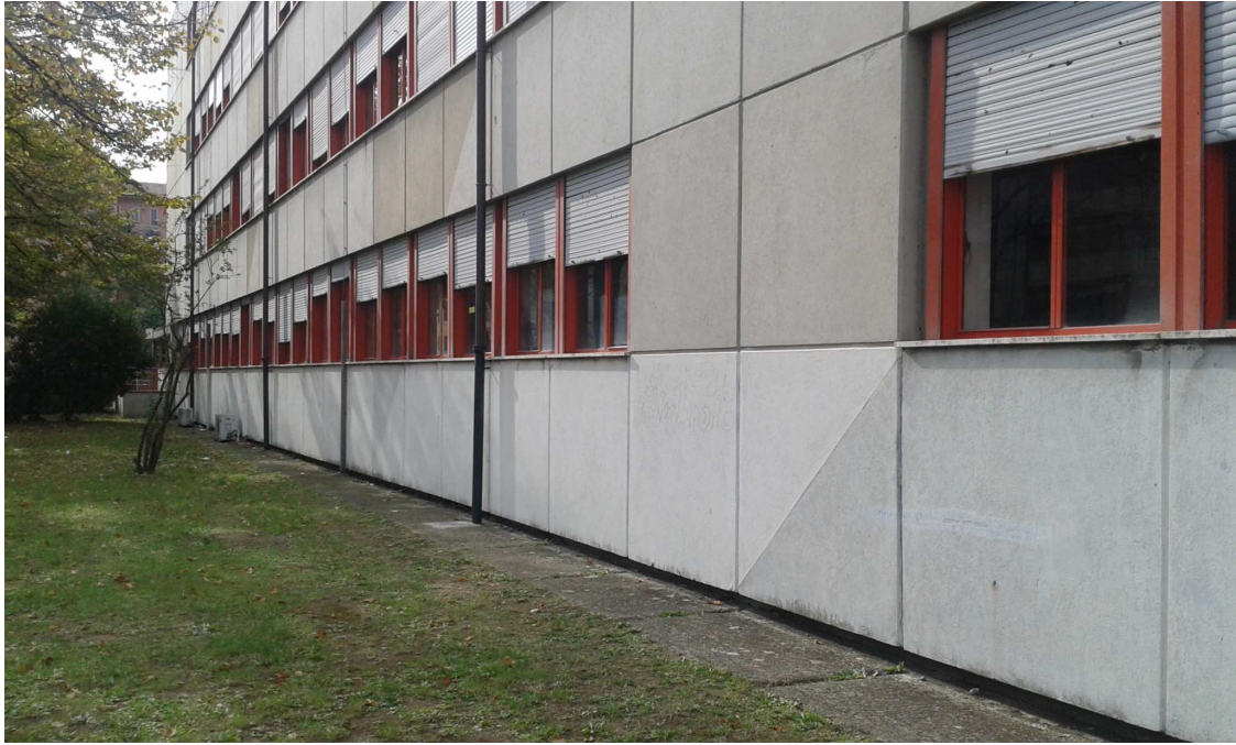
Pareti perimetrali dell'edificio scuola
