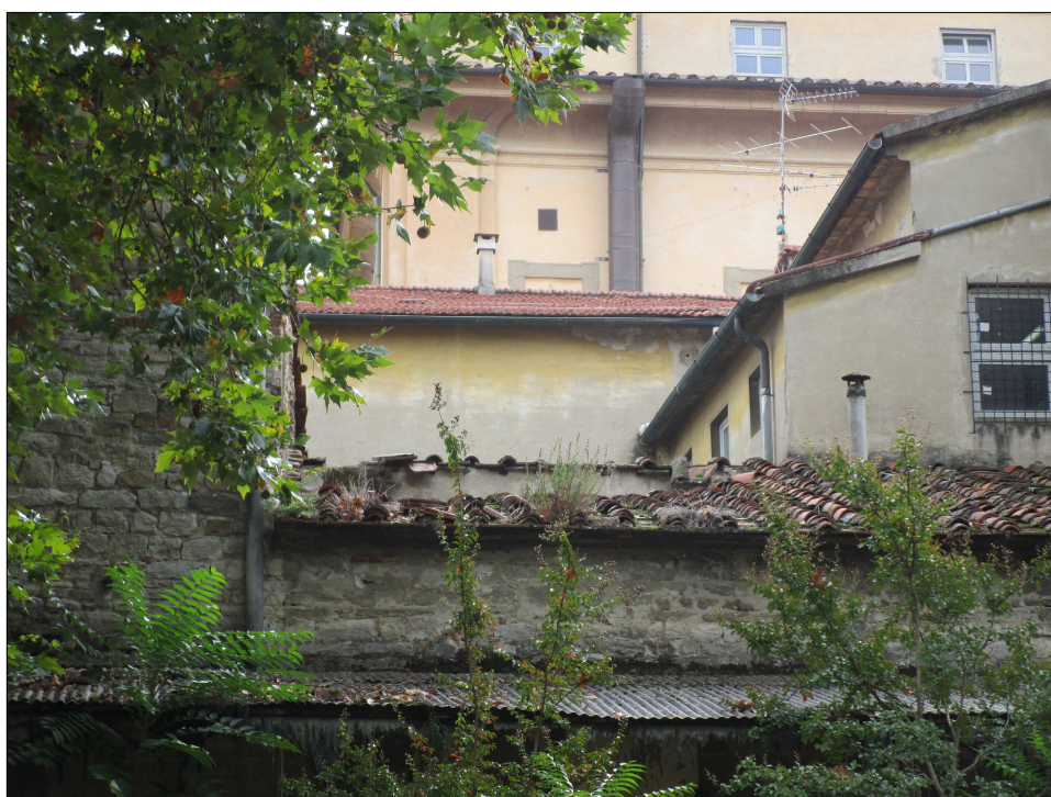
Foto 8 : copertura magazzino lato est
