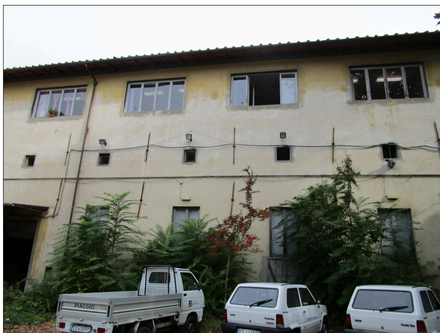
Foto 2 : gronda tetto lato corte
