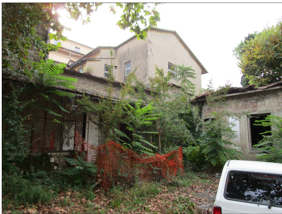
Foto 7 : magazzino lato est
