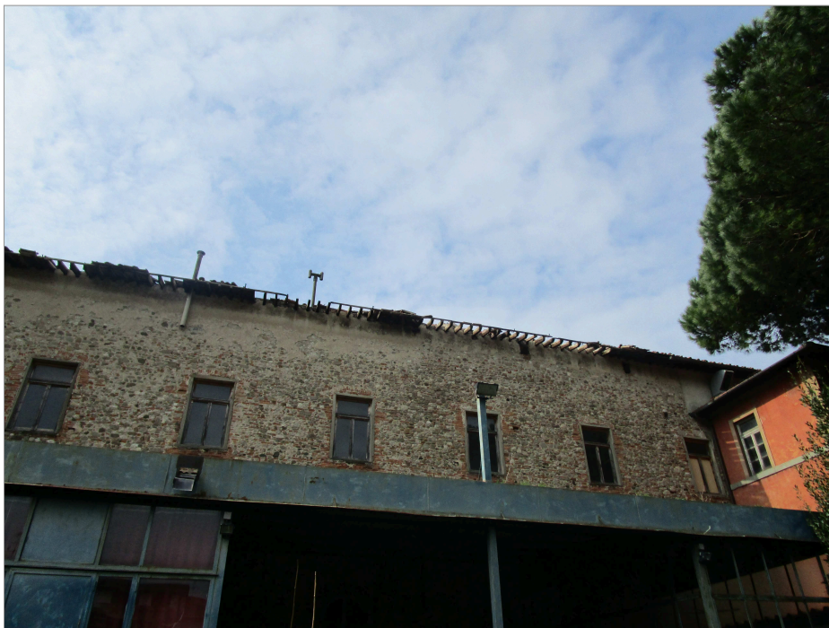
Foto 4 : particolare copertura lato corte
