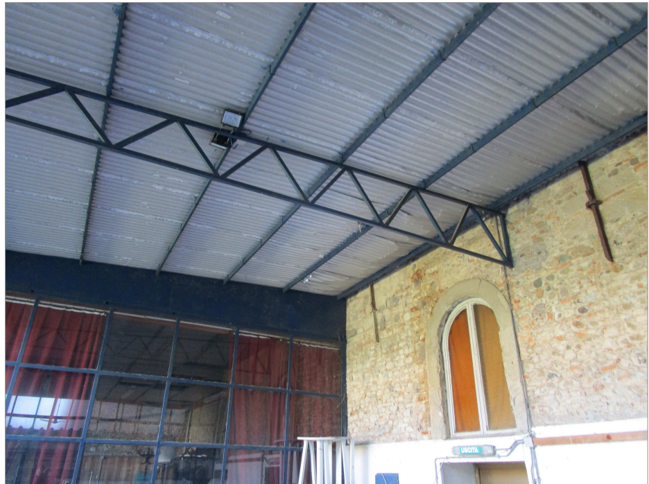
Foto 3: vista interna copertura in lamiera metallica
