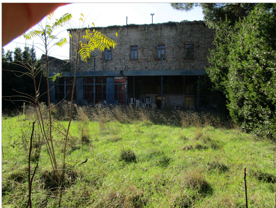
Foto 2 : gronda tetto lato corte
