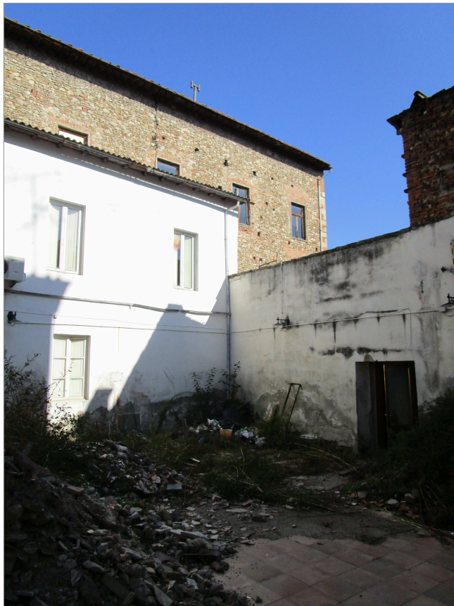
Foto 7: vista della copertura del monastero dalla corte interna
