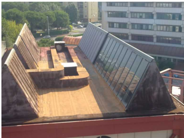
1) Copertura , “shed” , canali e struttura a vista
