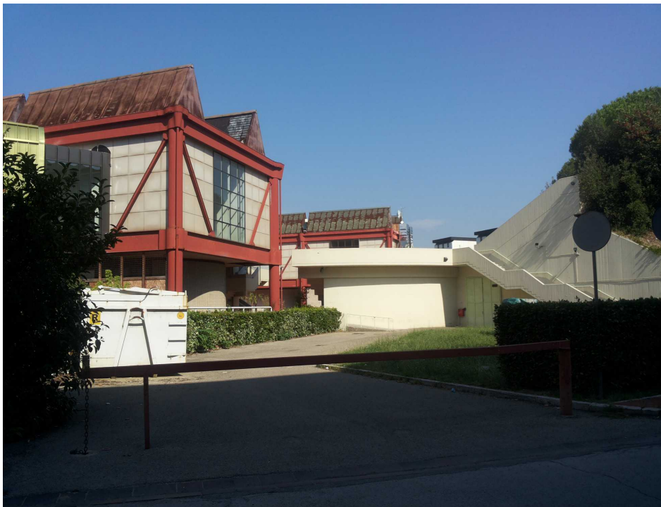
15) Retro area da adibire a ingresso mezzi per il cantiere
