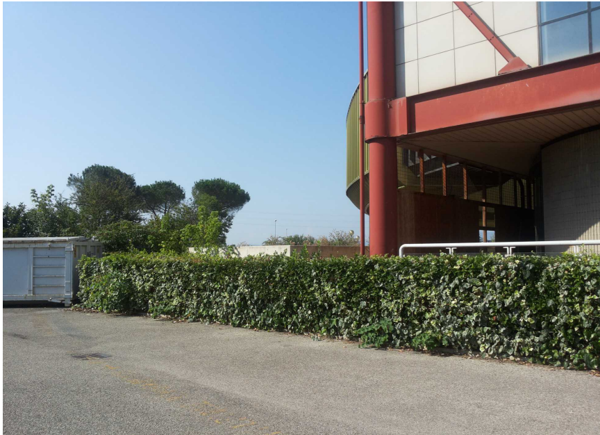
16) Viabilità interna lato rampa
