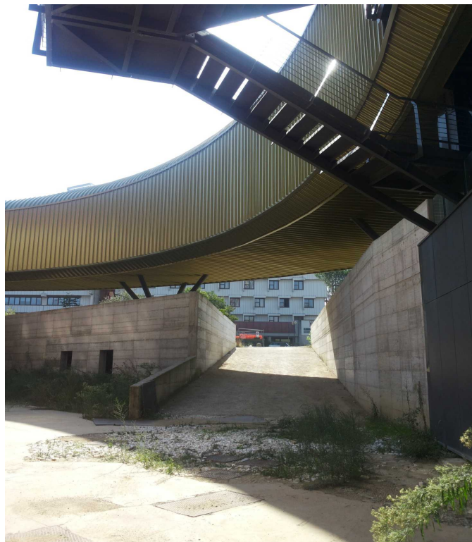
23) Corte interna e rampa
