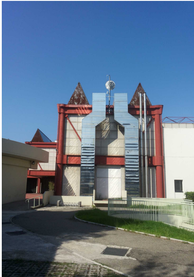
12) Retro area da adibire a a cantiere
