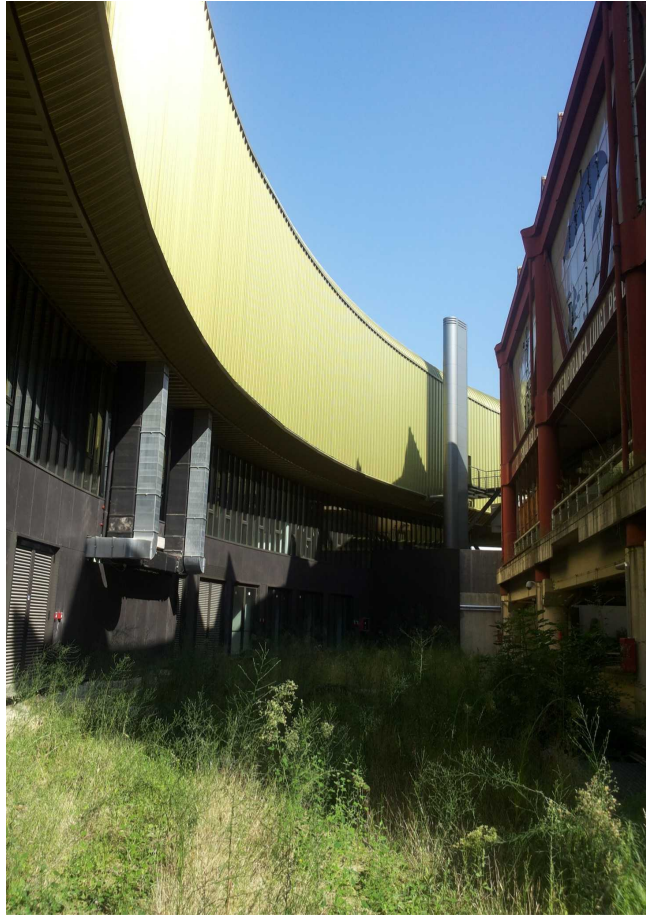
24) Corte interna a livello interrato
