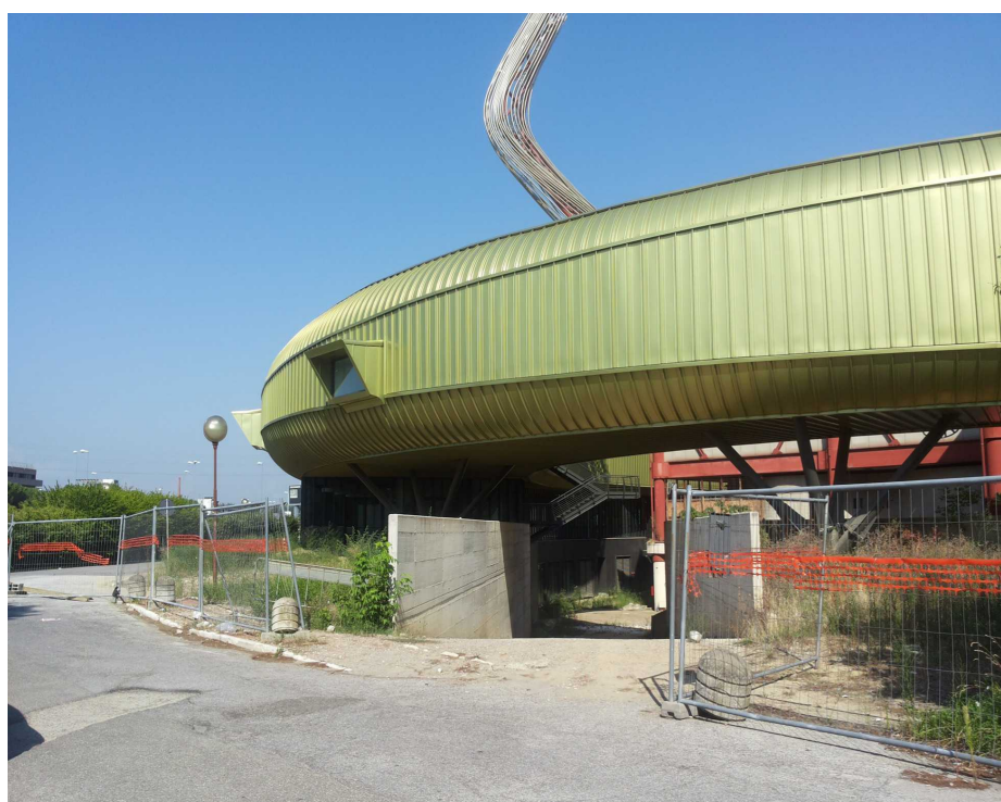
21) Rampa di accesso al piano interrato
