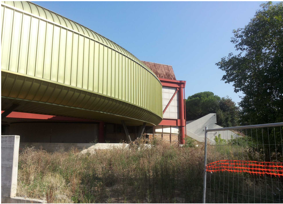
22) Vista del punto di attacco fra i due edifici in prossimità della rampa
