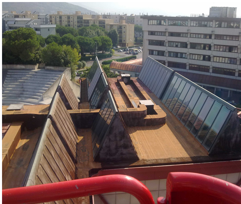
30) Vista della copertura 31)
