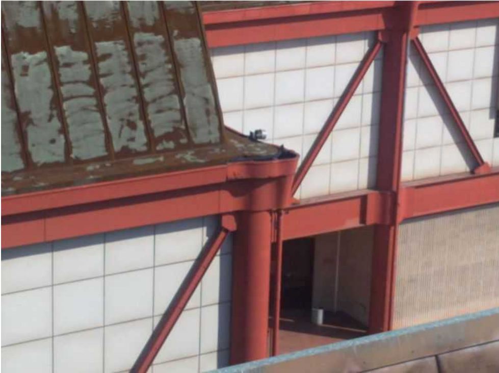
26) Particolare del punto fra copertura e facciata
