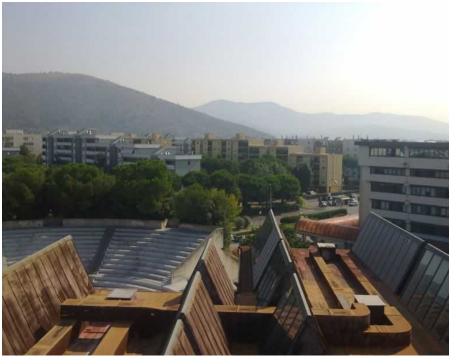
24) La copertura vista verso l'anfiteatro
