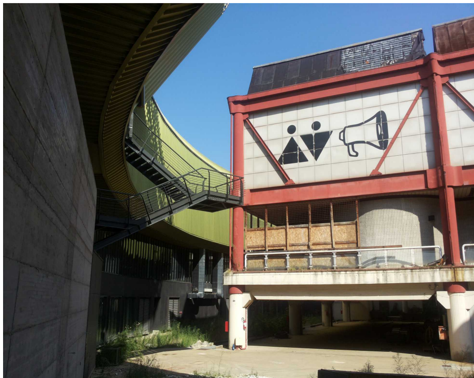
23) Corte interna a livello interrato
