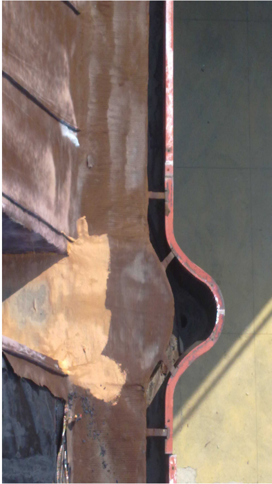
28) Canale di gronda
