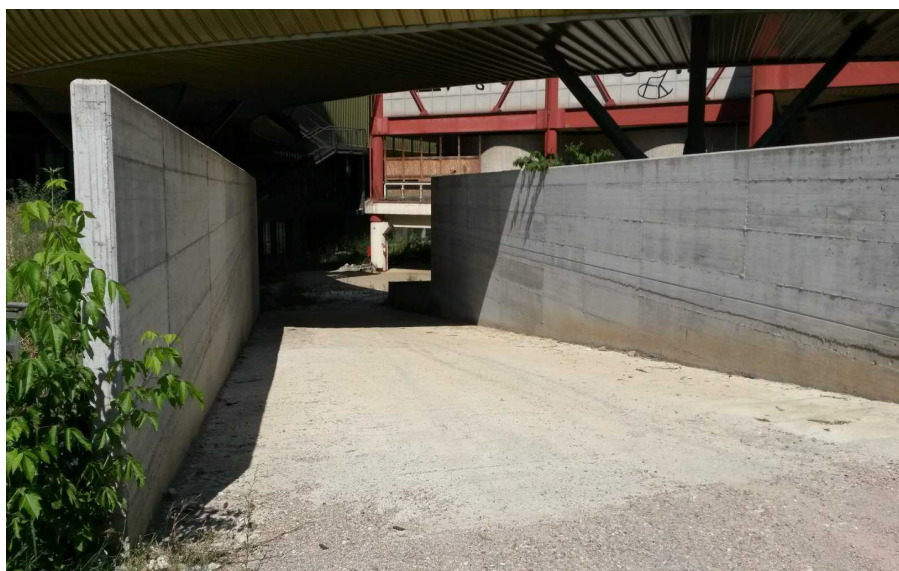
20) Rampa di accesso al piano interrato
