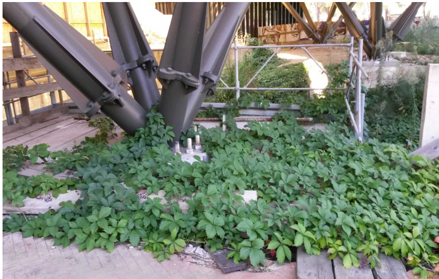
14) Terreno interessato dalla realizzazione muro a retta e riempimento
