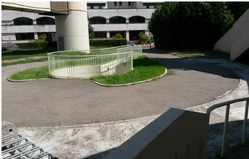
15) Terreno interessato dalla realizzazione muro a retta e riempimento
