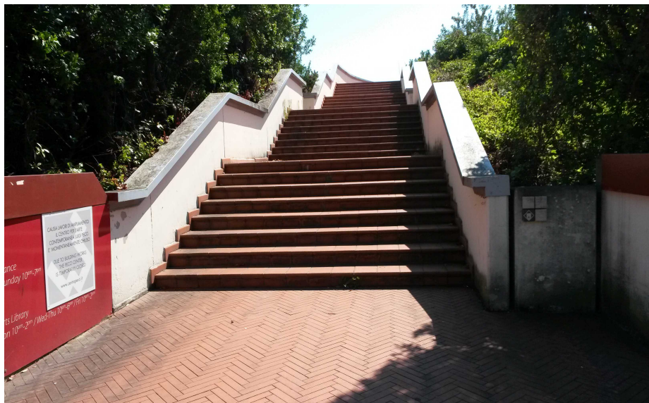
3) Passerella ingresso lato V.le della Repubblica
