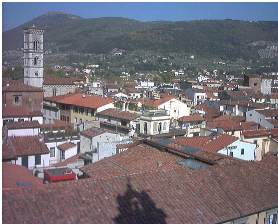
Veduta dei tetti con le torri evaporative
