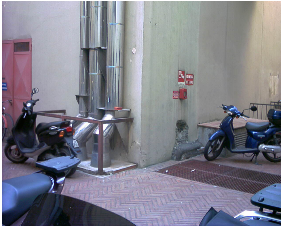
Veduta del Palazzo Comunale dalla C.T. con particolare delle canne fumarie
