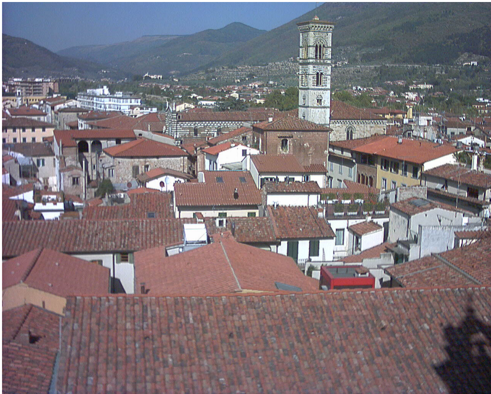
Veduta dei tetti con le torri evaporative
