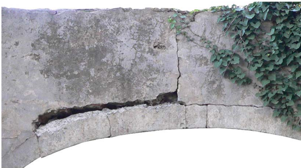
Parapetto del ponte, particolare - (prima del restauro)
