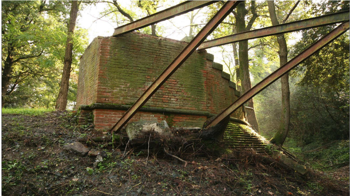
Ponte angolare della Corsa, rampe di adduzione in laterizio e pietra arenaria e ponte in ferro
