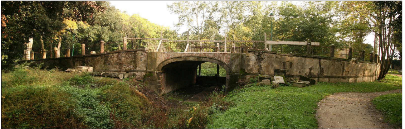
Ponte della Curva, veduta d'insieme del complesso dopo le prime opere di consolidamento
