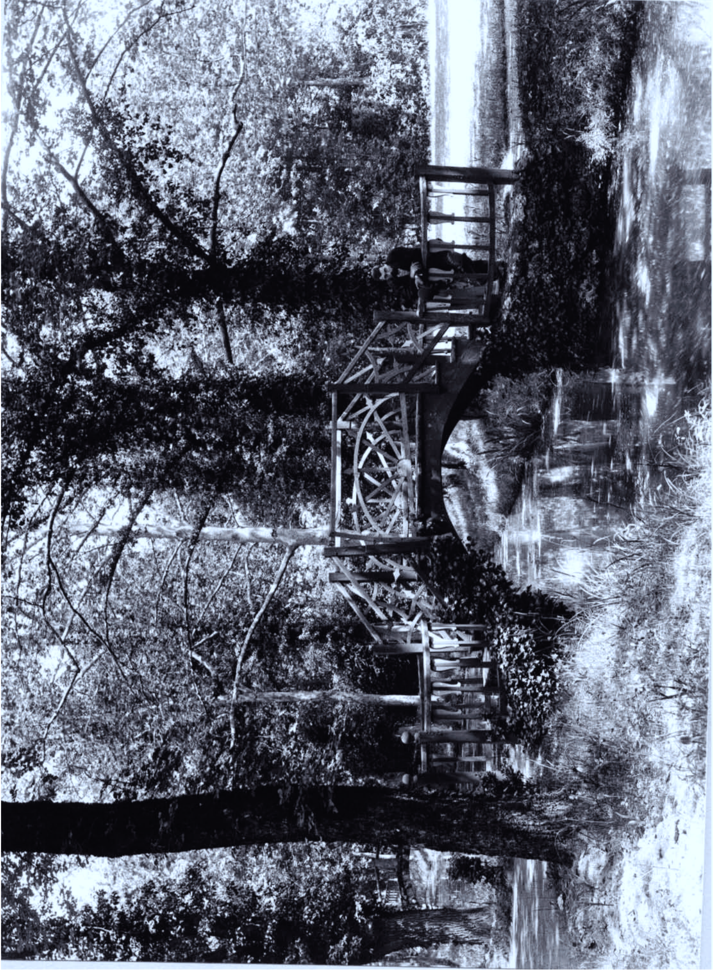
Ponte in Pietra Spugna e Legno, realizzato agli inizi del XVIII secolo e ripetutamente rimaneggiato, oggi allo stato di rudere.
