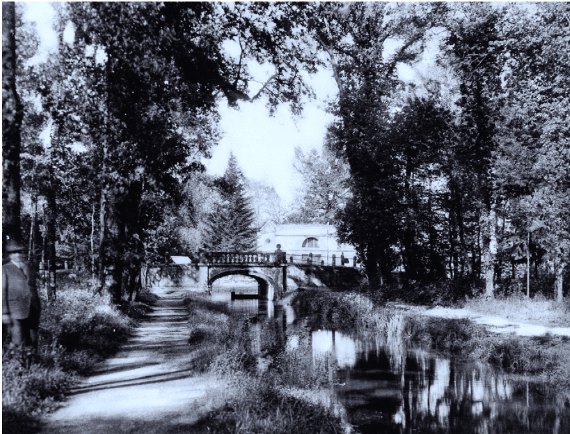
Il Ponte alla Curva sul Canale della Corsa in una foto d'epoca.
