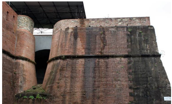
Firenze, Fortezza da Basso: Bastione d'angolo con troniera nel fianco e, a sinistra, disegno di progetto (A. da Sangallo il Giovane)
