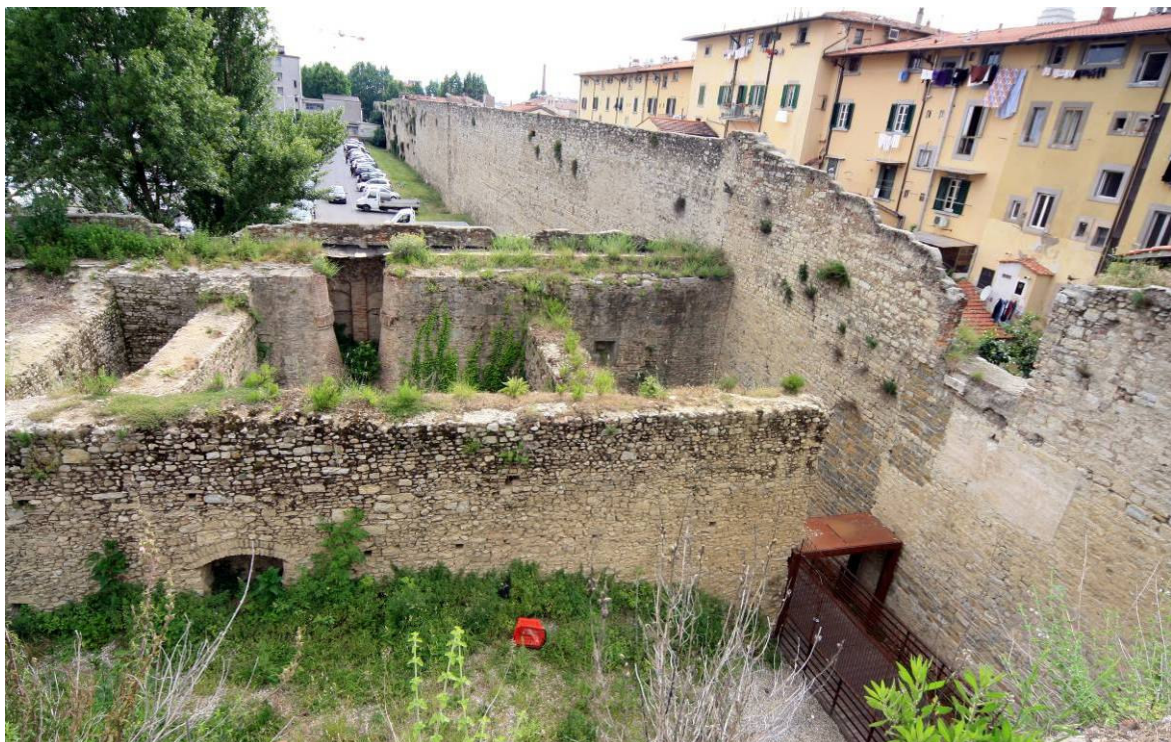
Vista panoramica delle strutture murarie emerse dallo scavo nel 2003
