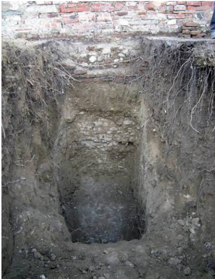
Scavo di assaggio dietro il parapetto superiore
