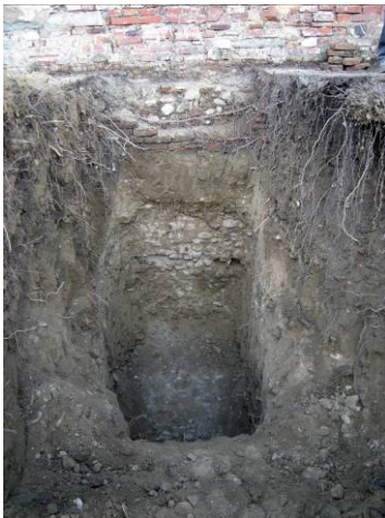
Saggio per la verifica della sezione muraria
