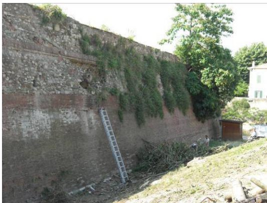
Fronte sud: diserbo del paramento (maggio 2011)
