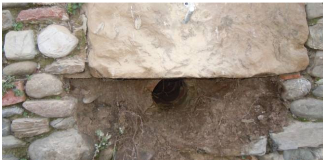
Carotaggio nella muratura sommitale
