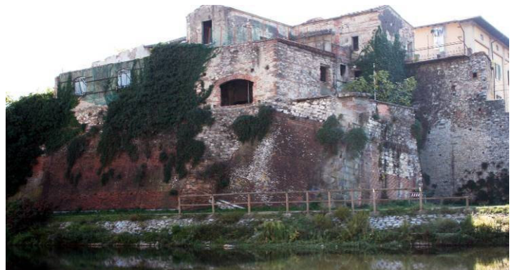
Cedimento fondale del Bastione delle Forche
