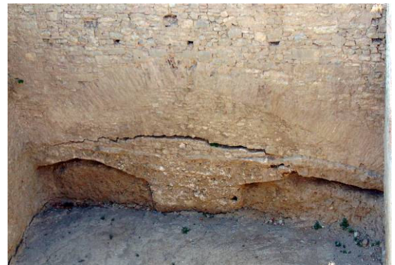
L'arco di scarico e il sottostante innesto delle voltine crollate
