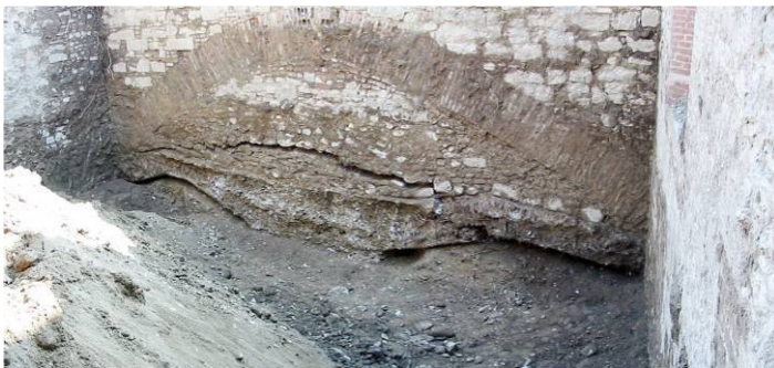
L'arco di scarico e il sottostante innesto delle voltine crollate
