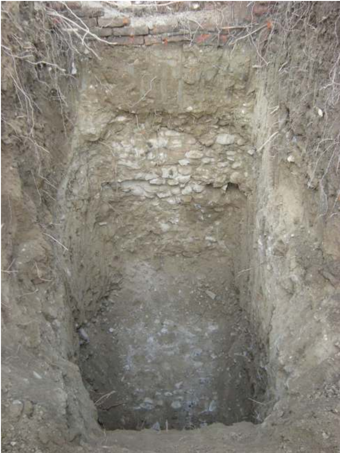
Particolare del cambio di sezione della muratura; si noti in fondo scavo la muratura scoperta
