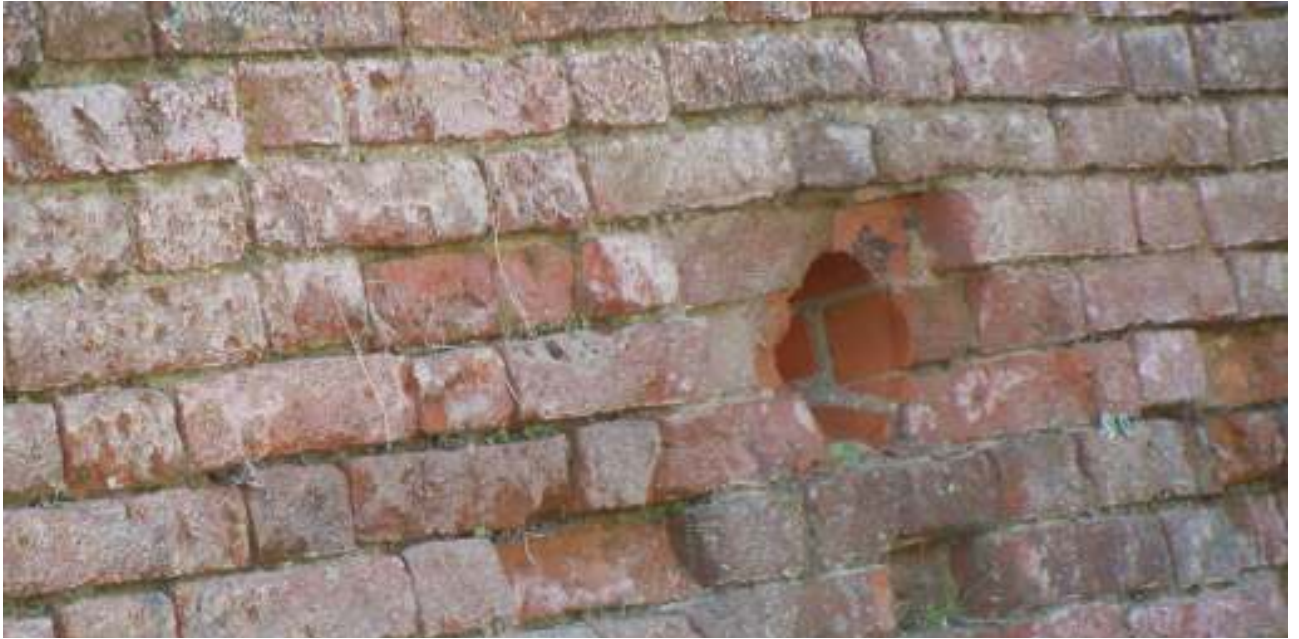
Posizione carota alla base della muratura
