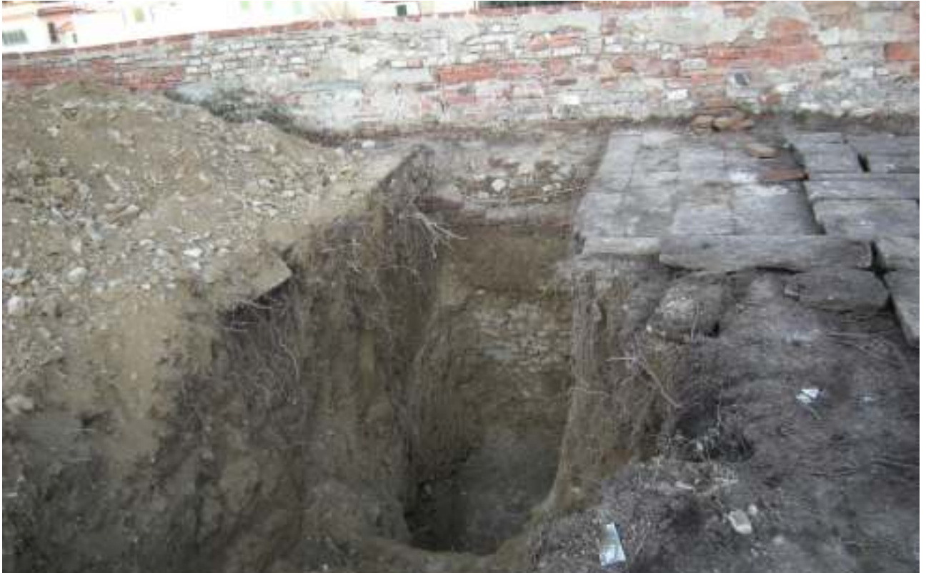
Particolare dello scavo
