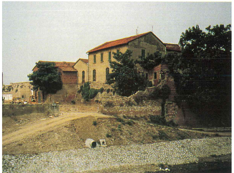
FOTO ANGOLO SUD-EST PRIMA DELLA DEMOLIZIONE DELLE SUPERFETAZIONI E DELLA MODIFICA DELL'ARGINE
