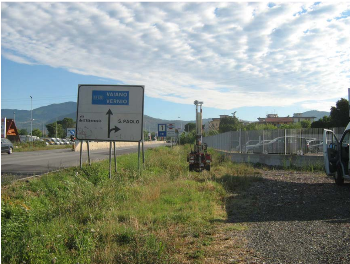
Foto 1 e 2 - Panoramica con ubicazione prove penetrometriche CPT1 e CPT2.
