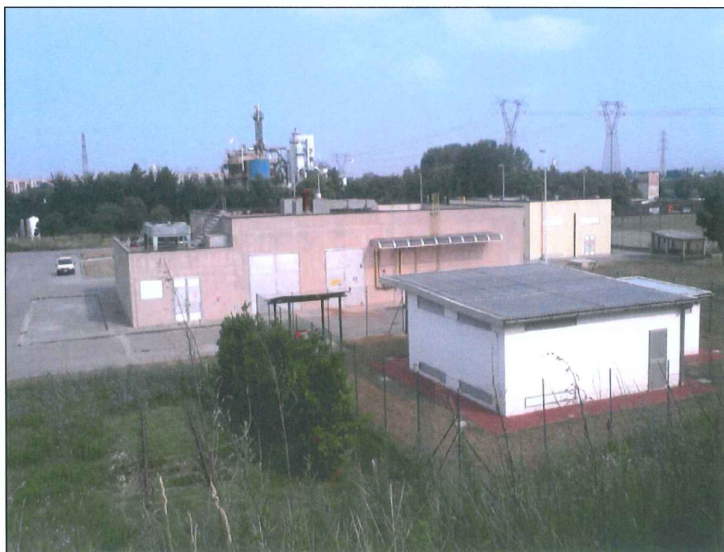
Foto 2. Panoramica area impianto Re.Mi., Impianto Turboespansione e deposito THT.
