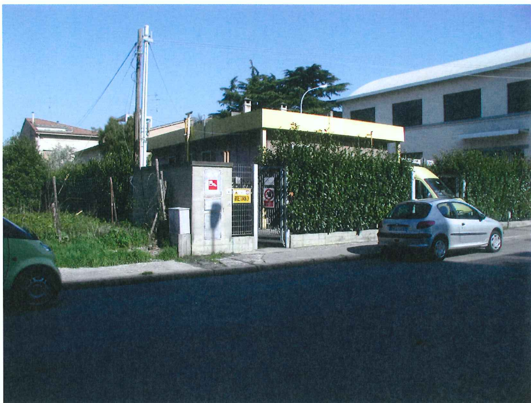
Foto 1. Panoramica area Cabina
