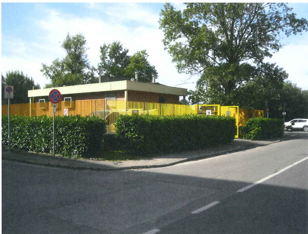
Foto 1. Panoramica area Cabina
