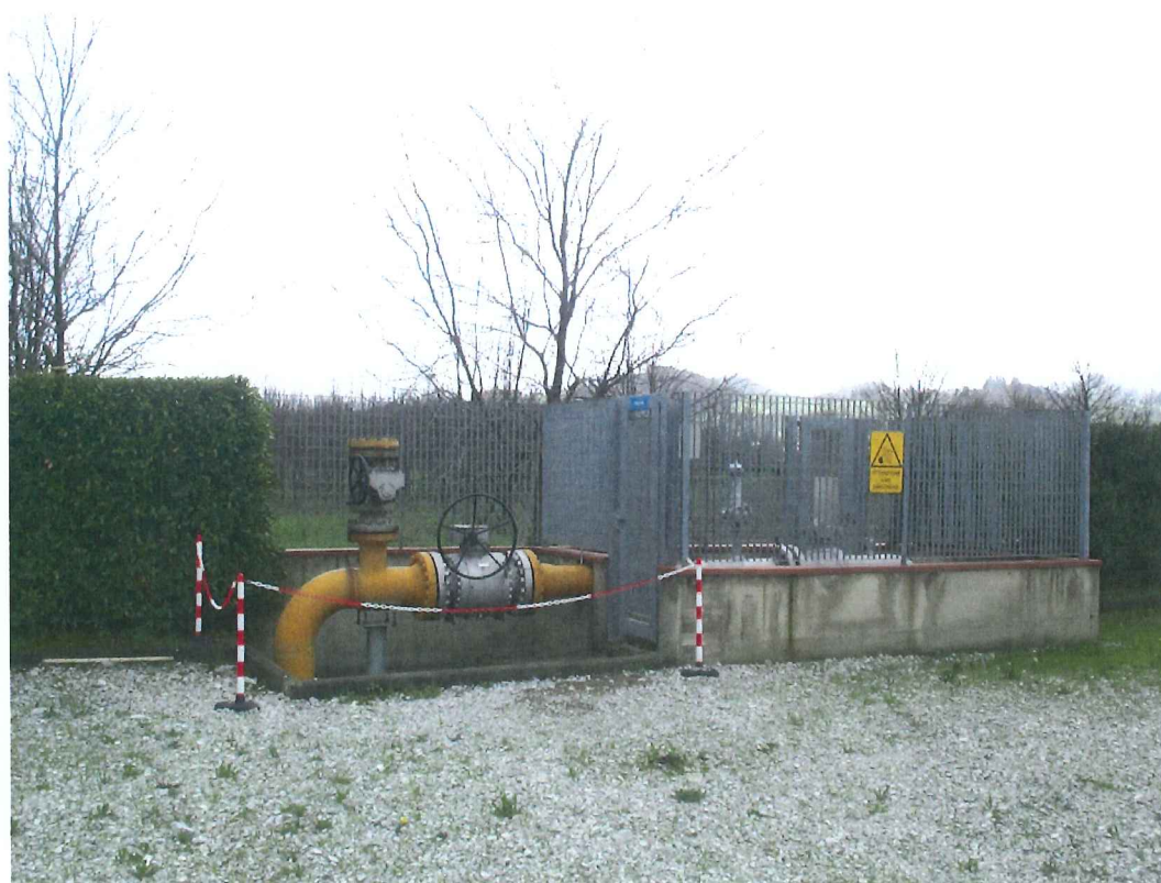
Foto 2. Punto di consegna SNAM ed attacco carro bombolaio
