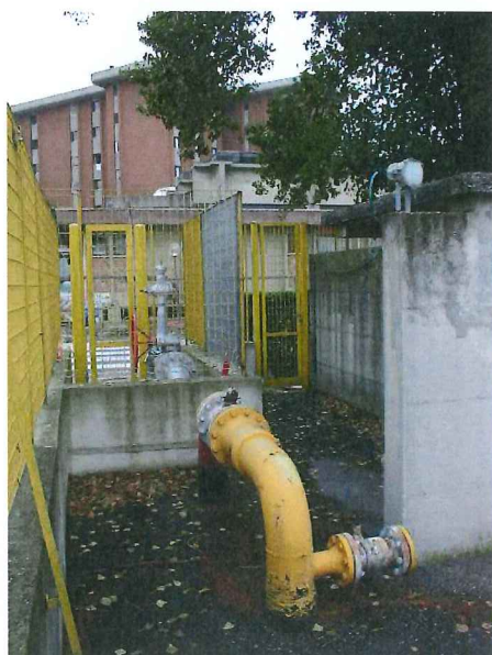
Foto 2. Punto di consegna SNAM ed attacco carro bombolaio
