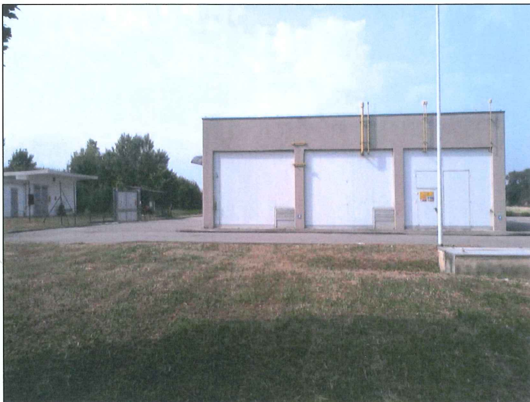
Foto 10. Impianto di turboespansione – Fabbricato.
