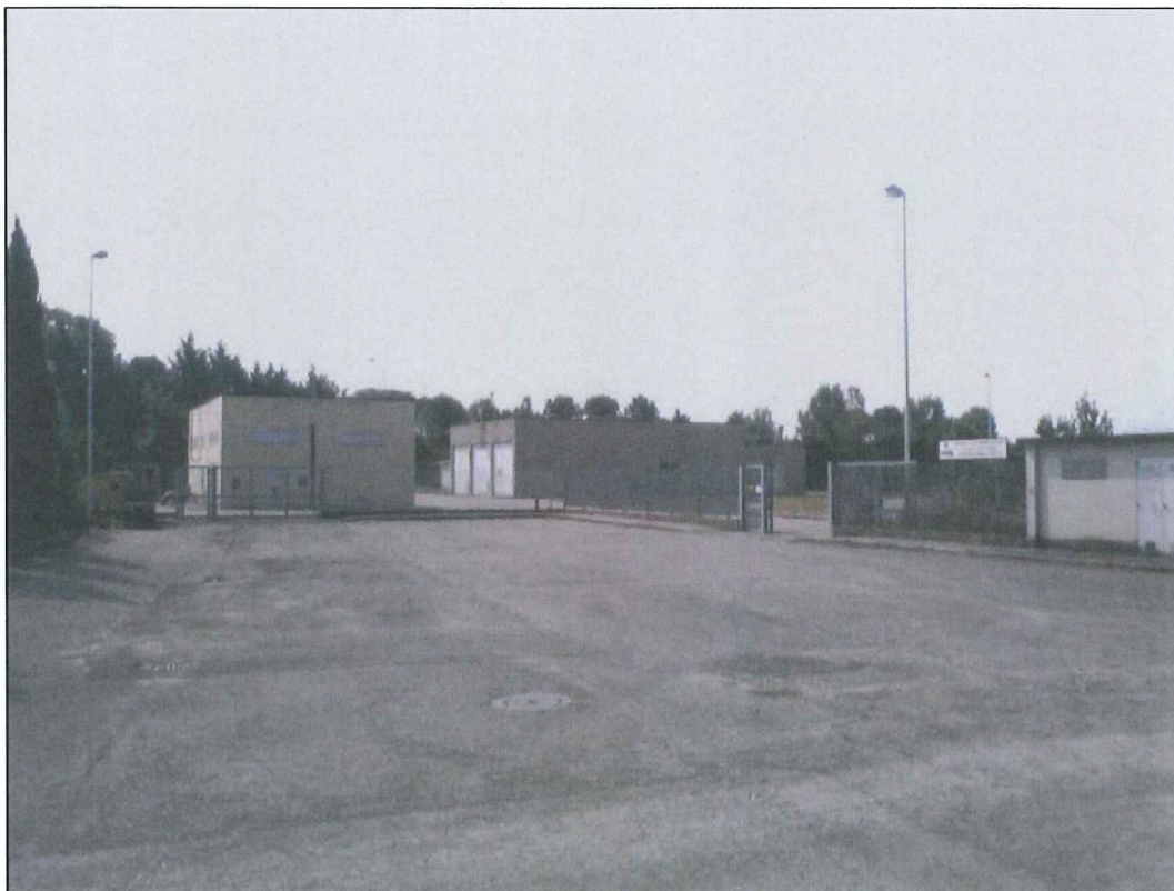
Foto 1. Panoramica area impianto Re.Mi., Impianto Turboespansione e deposito THT.
