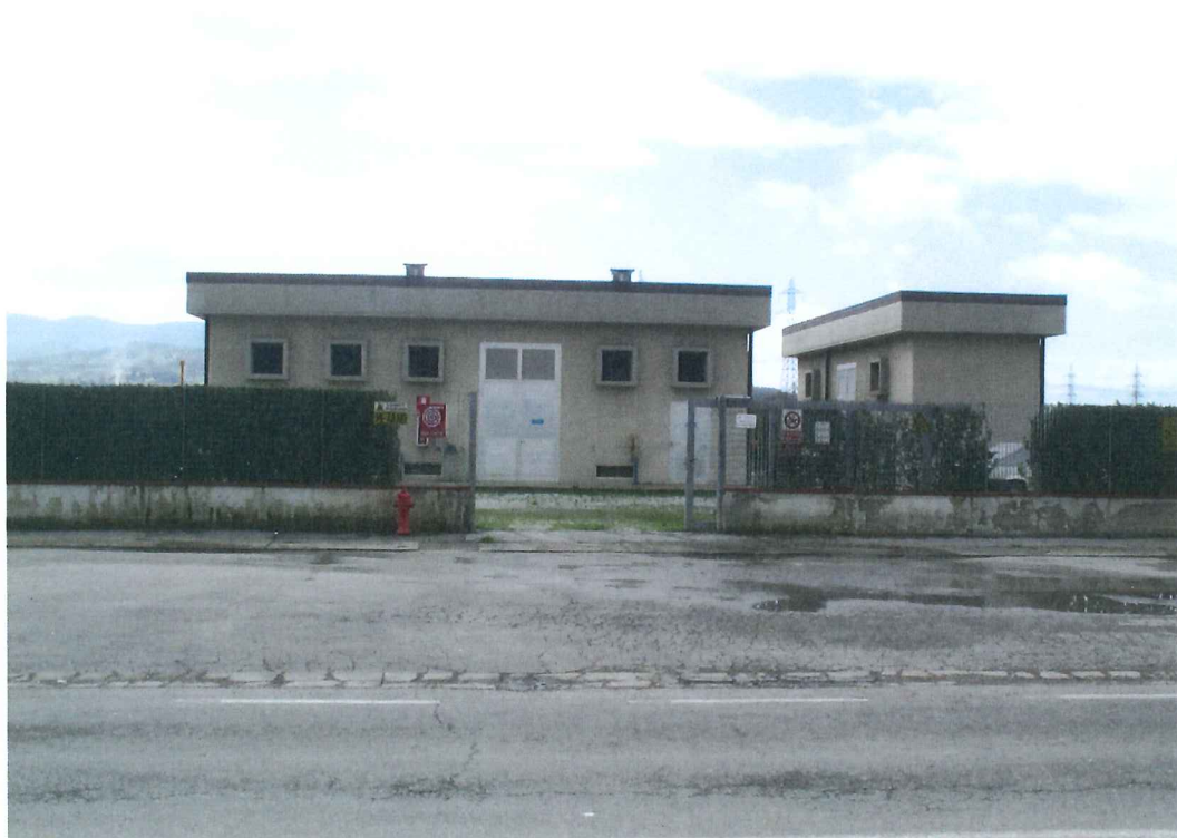
Foto 1. Panoramica area Cabina
