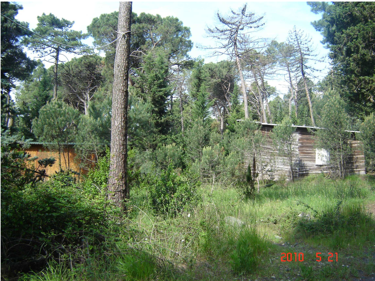
Foto 8 (Vista area inserimento Magazzino e Rimessa mezzi)
