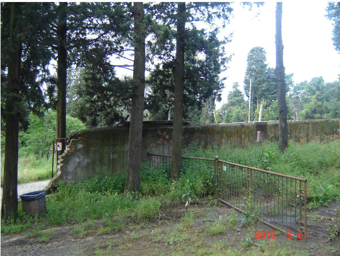
Foto 2 (Muro in mattoni da abbattere lato posteriore)
