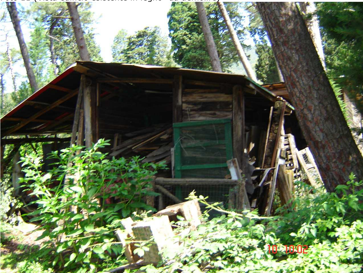
Foto 12 (Vista tettoia esistente in legno- da demolire)
