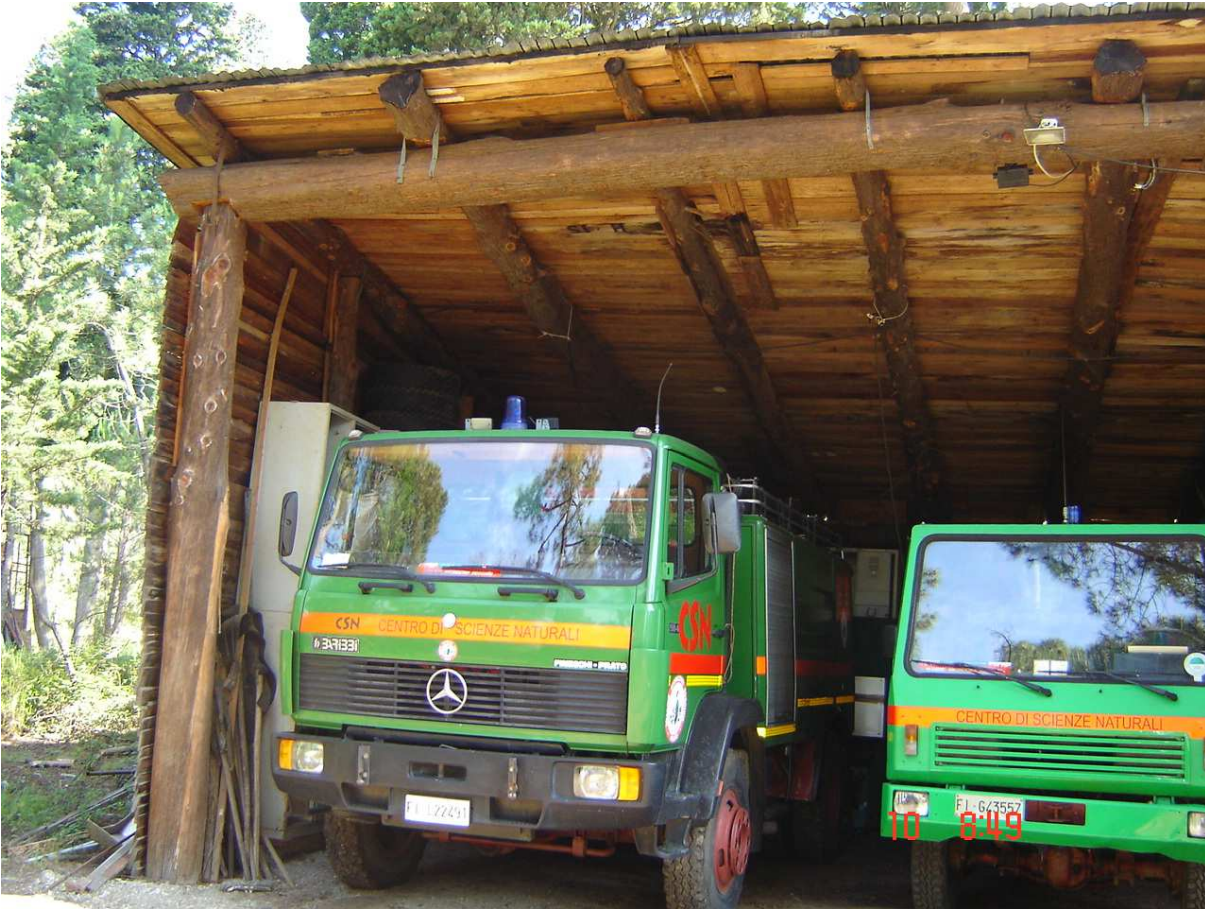
Foto 11 (Vista edificio esistente in legno- da demolire)
