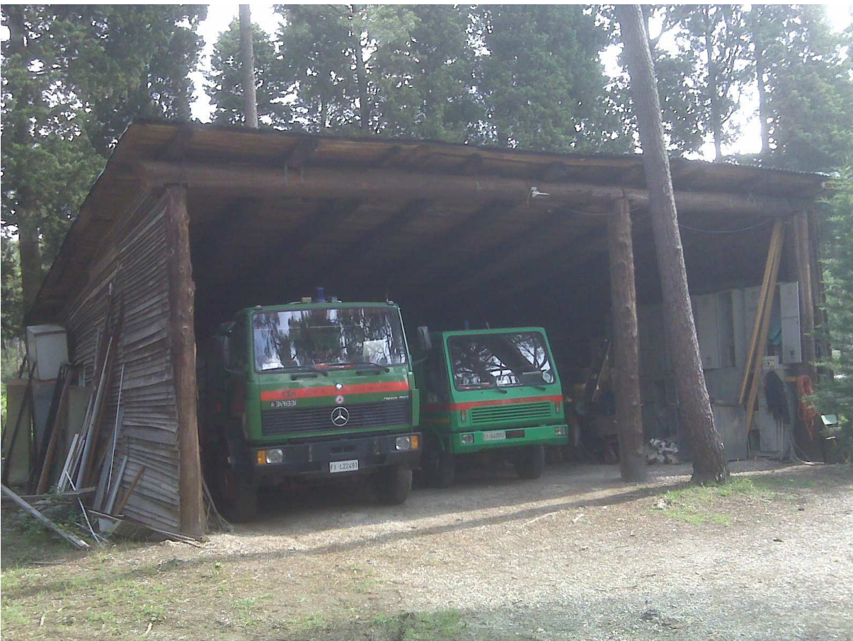
Foto 14 (Vista edificio esistente in legno- da demolire)
