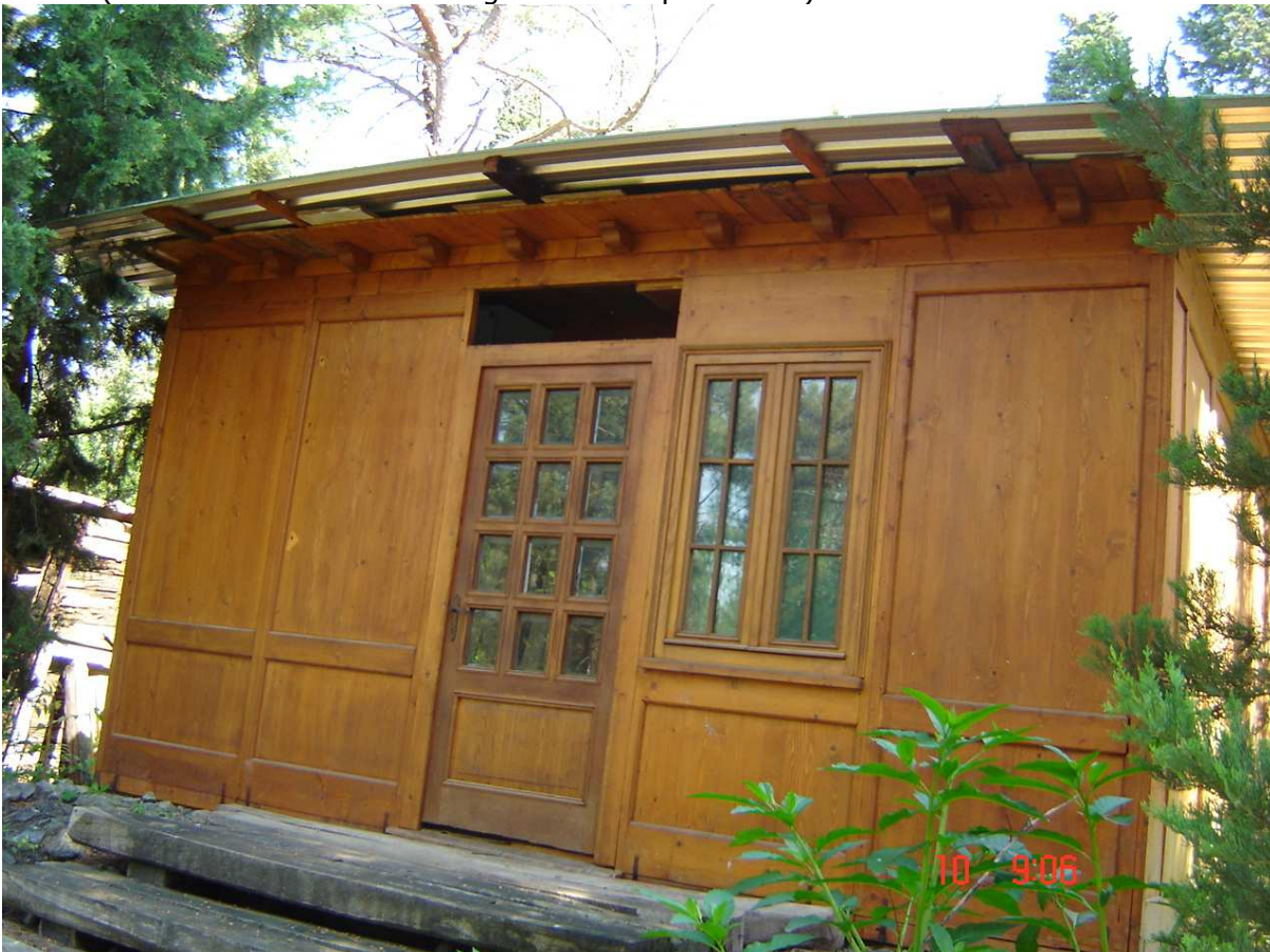
Foto 10 (Vista edificio esistente in legno- non da demolire)
