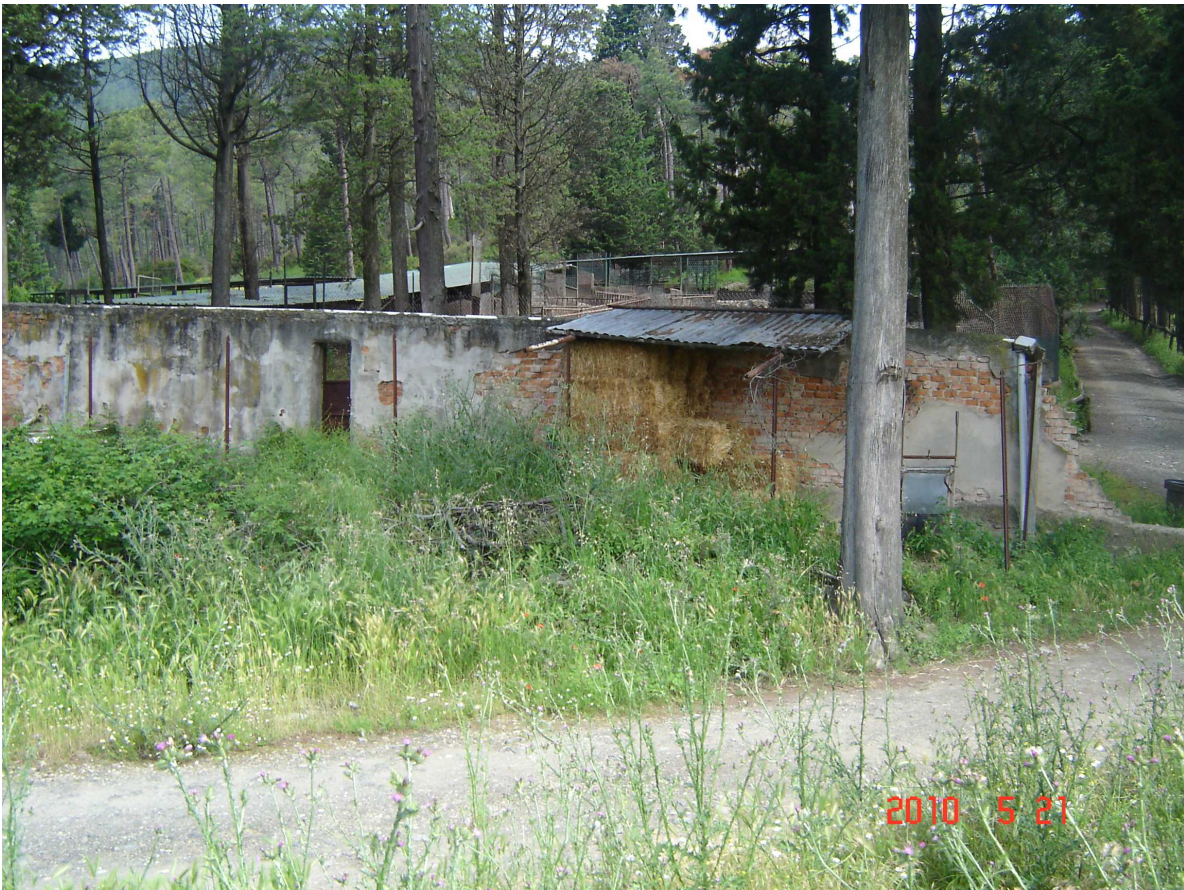
Foto 3 (Muro da abbattere lato anteriore)
