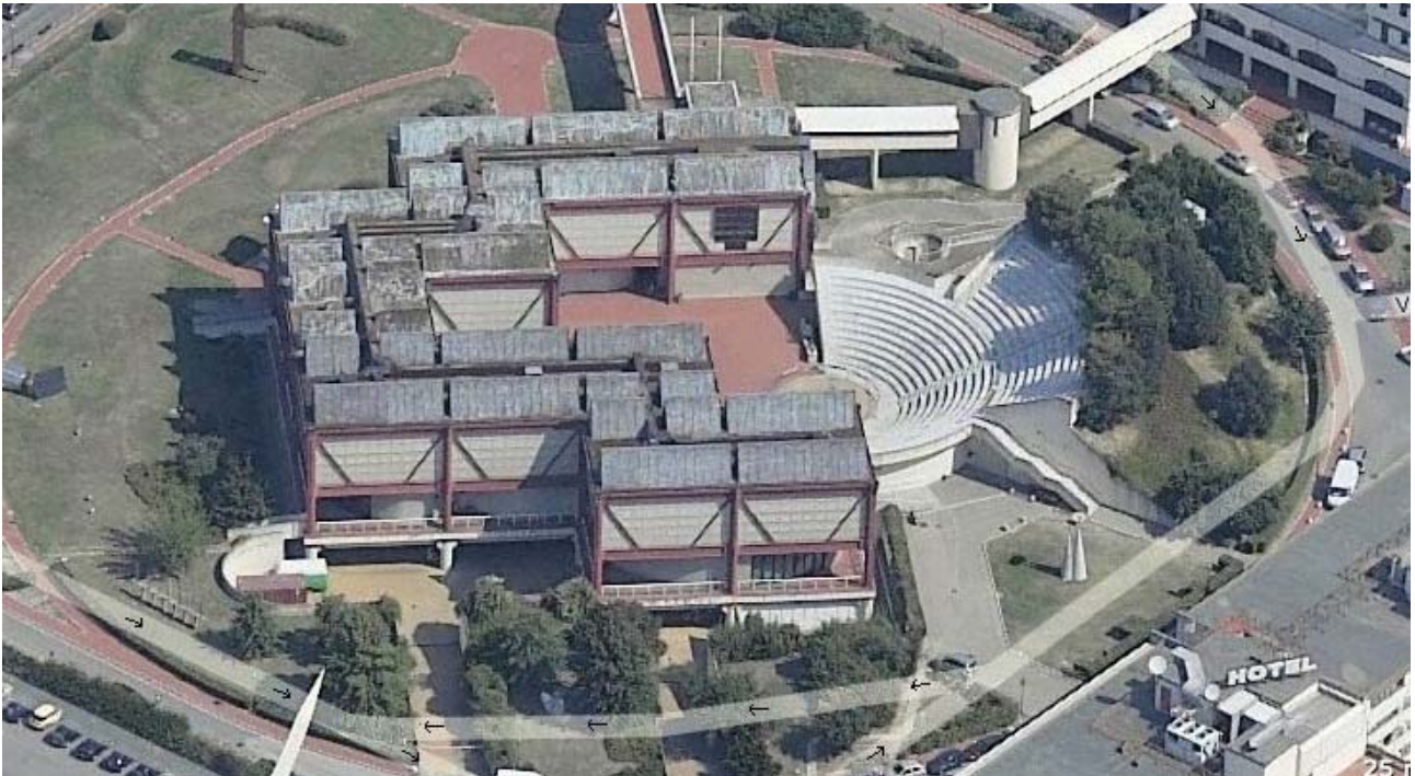
FOTO 1 Vista complessiva dall'alto
