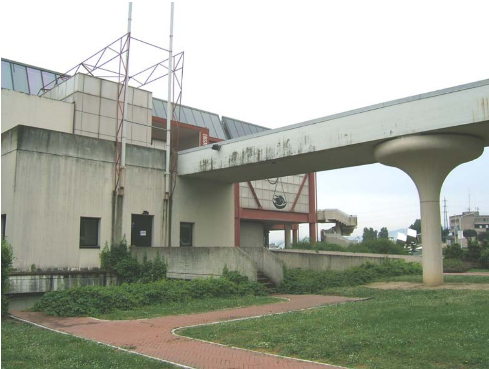
16 Particolare passerella ingresso piano primo
