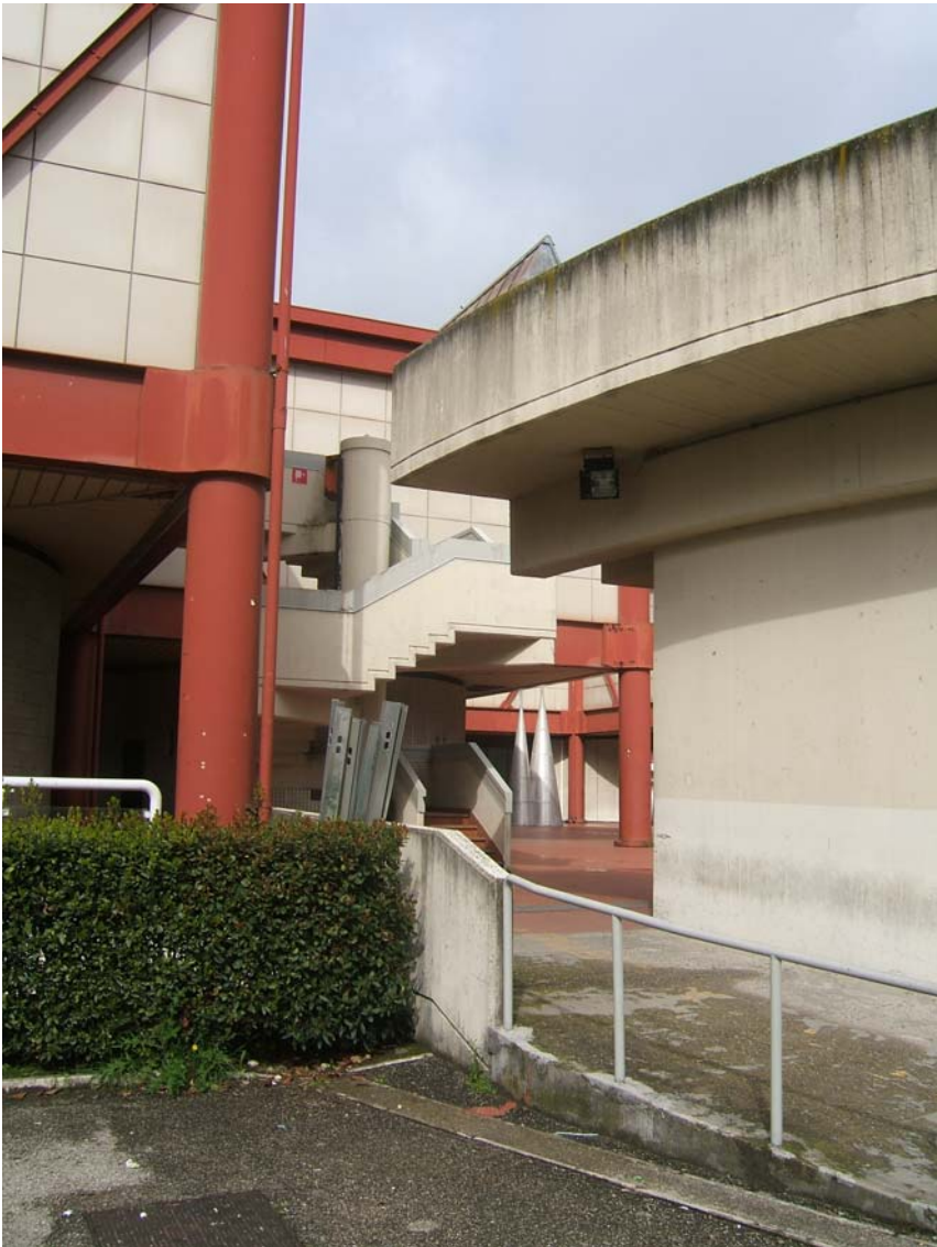
11 Particolare scala esterna uscita di sicurezza lato piazza interna
