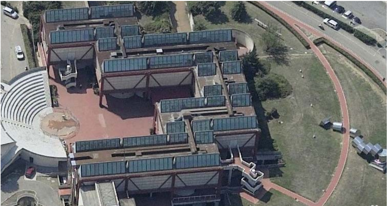
3 Le coperture dell'edificio esistente
