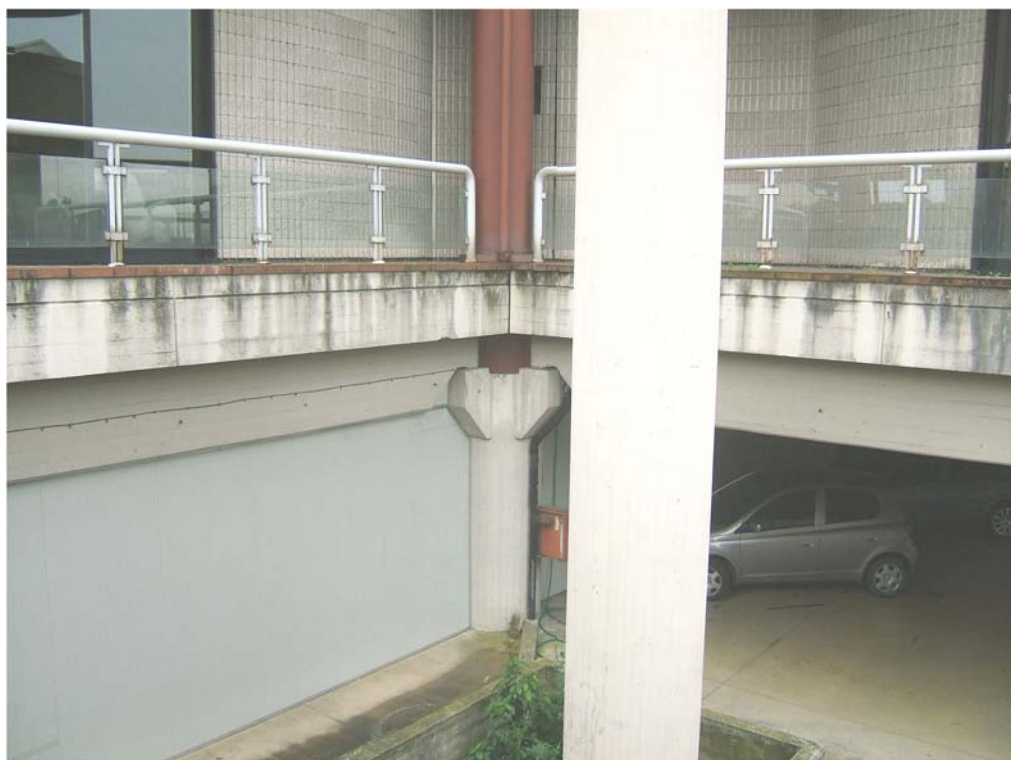
18 Particolare pareti vetrate piano terra
