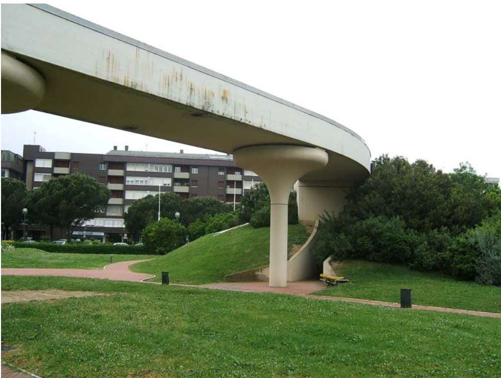
17 Particolare passerella ingresso piano primo
