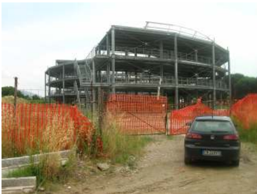
Fig.2 Accesso esistente all'area di cantiere
