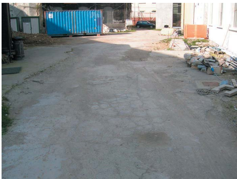
9. Manto di asfalto di fronte al Blocco A
