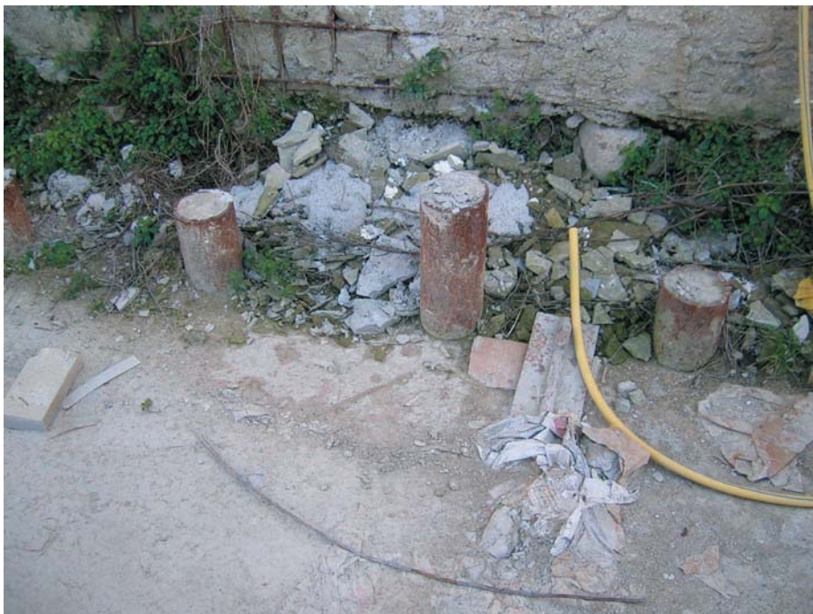
4. Particolare dei micropali
