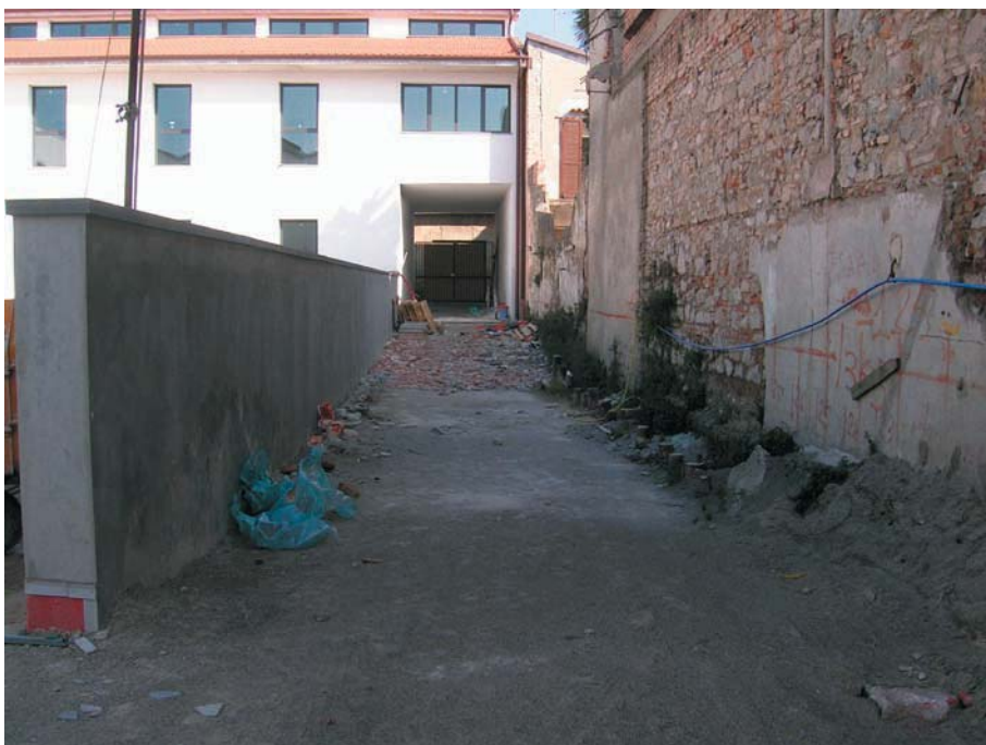
5. Rampa di accesso alla piazza
