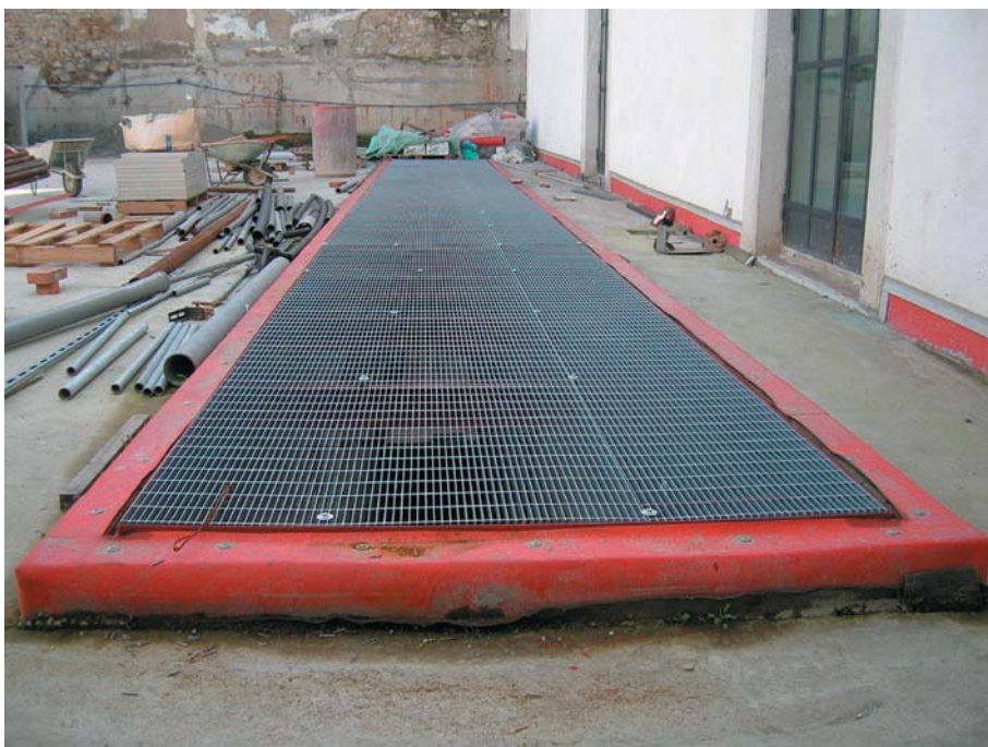
6. Griglia di aerazione in acciaio zincato antitacco tipo Orsogrill
