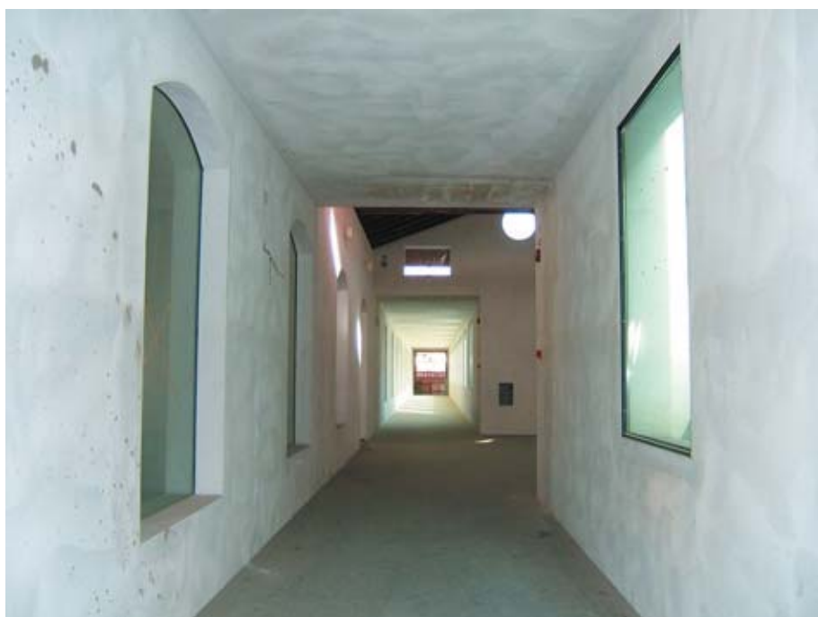
20. Galleria piano primo
