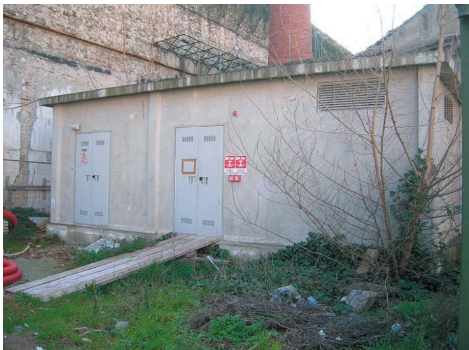
12. Cabina ENEL in demolizione
