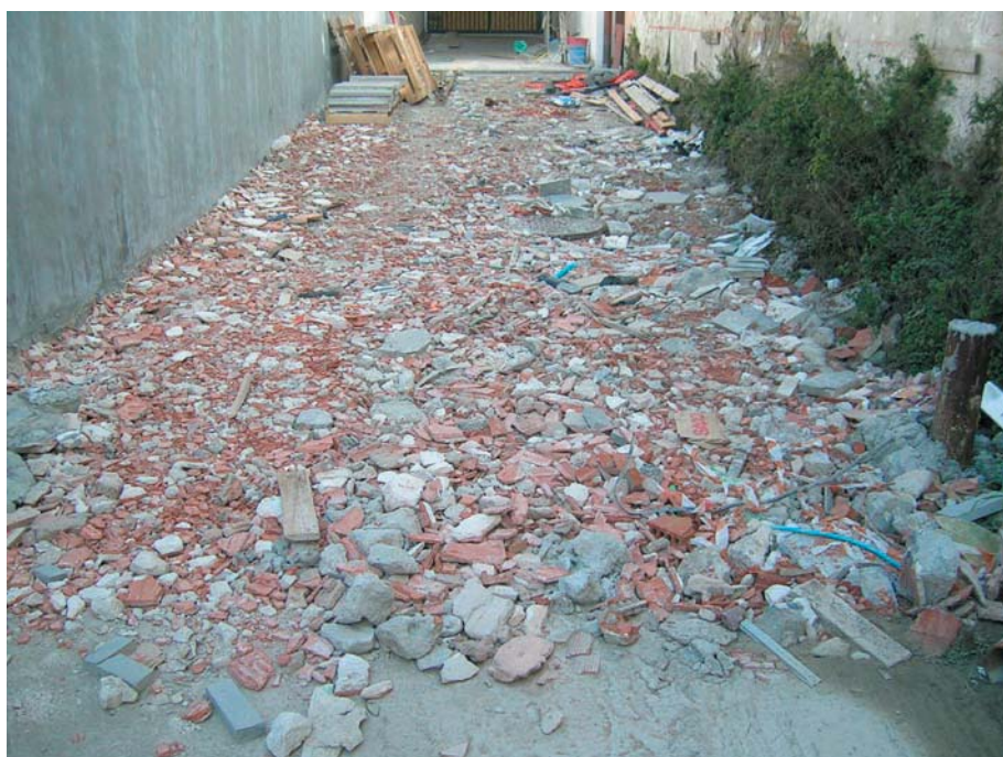
2. Particolare del piano di calpestio della rampa di accesso alla piazza costituito da materiale edile di riporto
