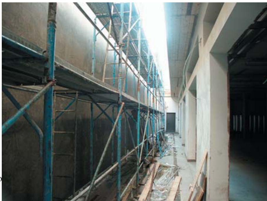
39. Deposito librario esterno
