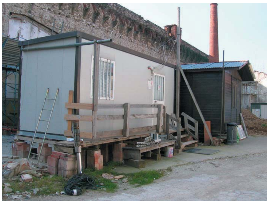
8. Baracche di cantiere di fronte al Blocco A
