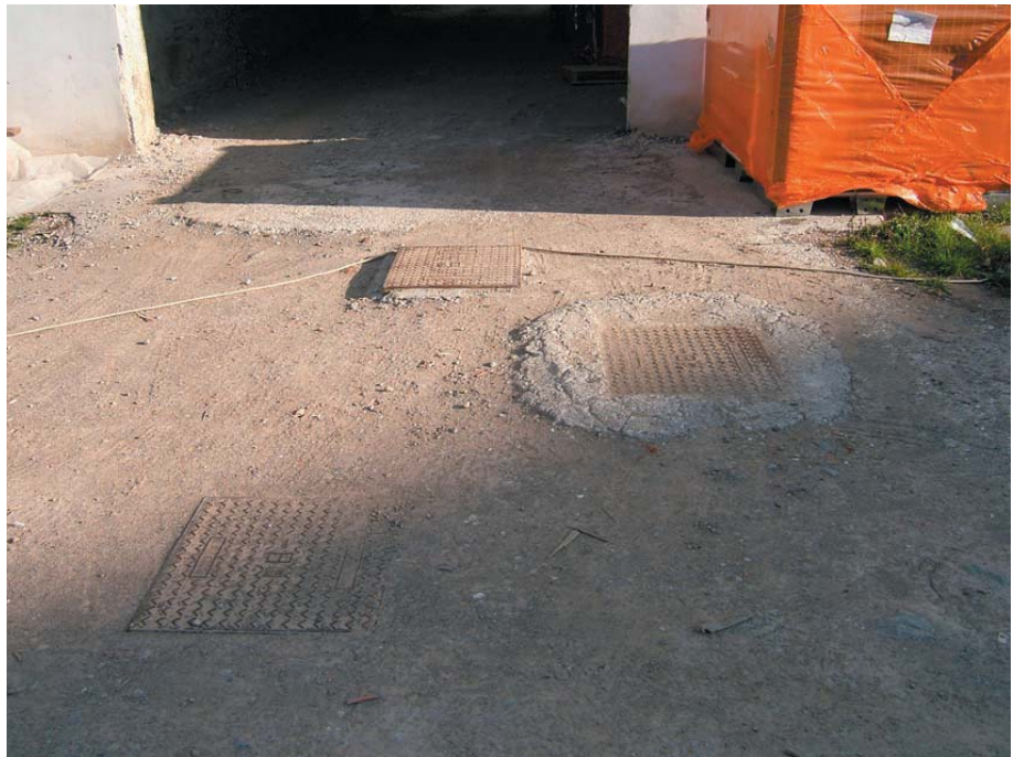
10. Chiusini in ghisa di fronte al Blocco A
