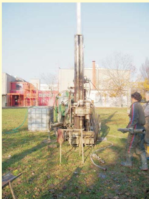
Ubicazione Sondaggio n° 1
